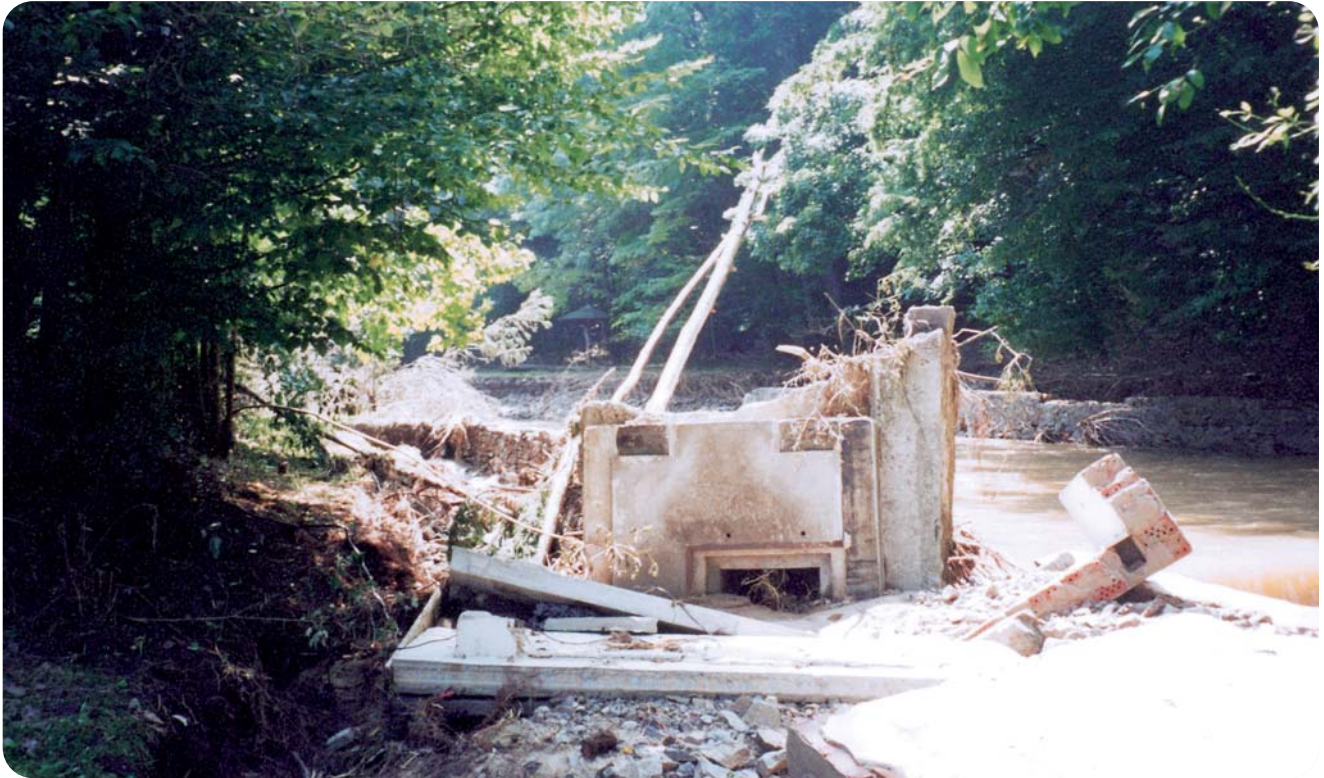
Abb. 7: Zerstörter Pegel Hainsberg 1/ Rote Weißeritz
