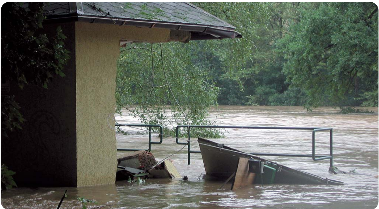
Abb. 25: Zerstörter Pegel Wechselburg 1/ Zwickauer Mulde am 13.8.2002
