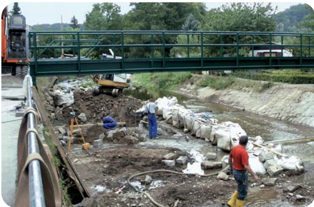
Abb. 29: Pegelbaumaßnahme Hainsberg 5/ Rote Weißeritz
