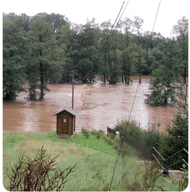
Abb. 20: Überströmung Seilkrananlage Wolkenburg / Zwickauer Mulde
