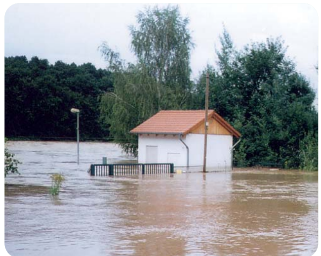
Abb. 8: Überflutetes Pegelhaus Golzern 1/ Vereinigte Mulde
