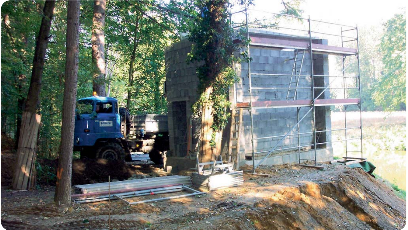
Abb. 26: Wiederaufbau Pegel Wechselburg 1/ Zwickauer Mulde im September 2003
