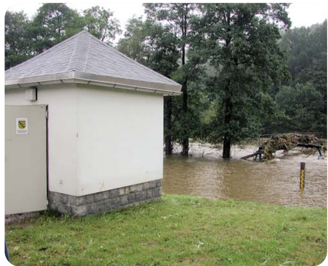
Abb. 19: Messsteg Pockau 1/ Flöha mit Überströmung und Baumanprall
