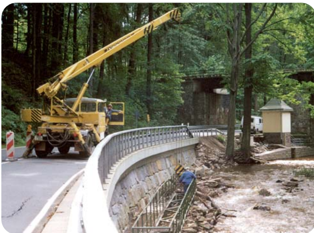
Abb. 11: Bergung des Messsteges Pegel Zöblitz/Schwarze Pockau
