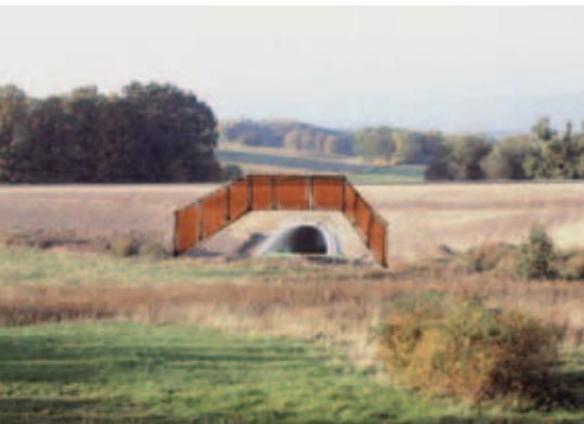
Foto 50: Fließgewässerunterführung in Kombination mit einer notwendigen, darüber dauerhaft installierten Sperrereinrichtung, die gleichzeitig einen Blendschutz bietet, um ein ungestörtes Unterqueren der Trasse für strukturgebundene Fledermausarten zu begünstigen (vgl. auch Foto 49). Entsprechende Leitpflanzungen zum Bauwerk sind noch zu ergänzen.
