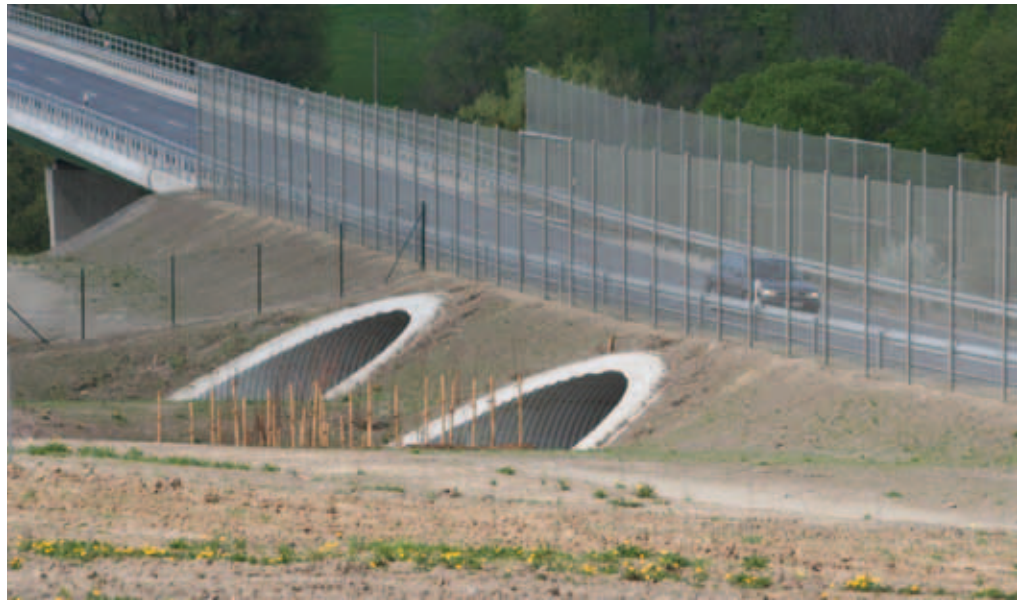
Foto 36: Fledermausdurchlässe in Verbindung mit Leitpflanzungen und trassenparallelen 4 m hohen Zäunen mit Leitfunktion an der S 170 n Friedrichswalde-Ottendorf
