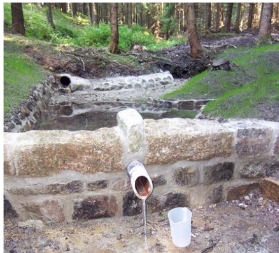
Abb. 5: Messung an der sanierten Quelle Jägersgrün
