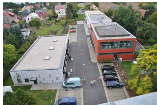
Abb. 3: Blick vom Turm auf Werkstattgarage (links), 1. Landesmessstelle (rechts vorn) und Bürogebäude (rechts hinten)
