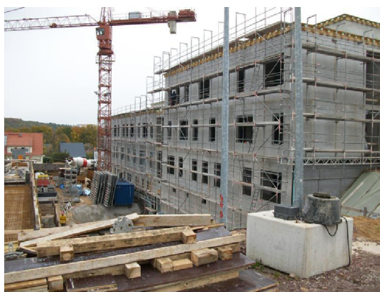
Abb. 6: Baustelle Nossen, Rohbau Haus 5
