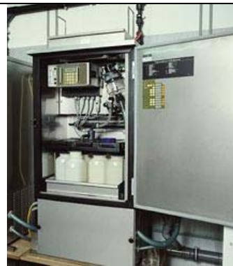
Kontinuierlicher Probensammler in einer Gewässergütemessstation
