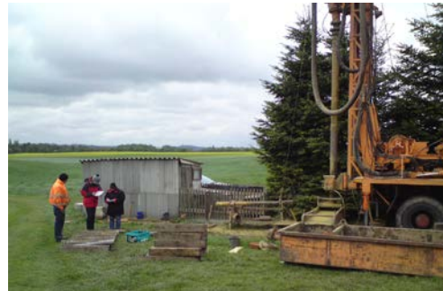
Abb. 2: Bohrgutansprache an der neu errichteten Grundwassermessstelle Claußnitz
