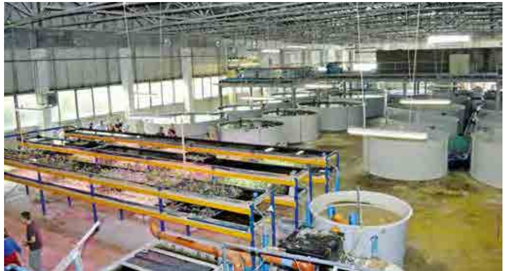
Aquakultur, Kreislaufanlage zur Erzeugung von Warmwasserfischen
