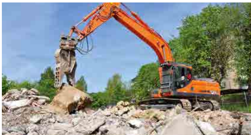
Rückbau nicht mehr sanierungsfähiger Bausubstanz
