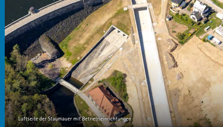
Hochwasserentlastungsanlage mit Fischbauchklappe
