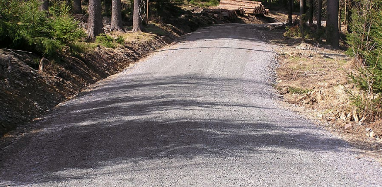
Gestaltung eines Weges mit Holzlagerplatz im Flurbereinigungsverfahren
