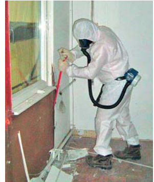
Arbeitnehmer in Schutzkleidung für den Abbau von alten Asbestinnenraumplatten
