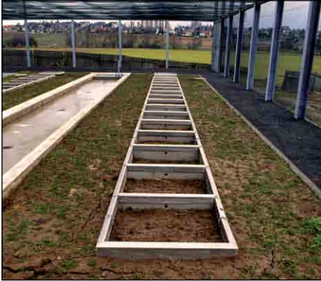
Abbildung 2: Blick auf die rechte Hälfte der Anlage mit 16 Lysimeterbehältern und umgebendem Simulierbeet vor Versuchsbeginn
