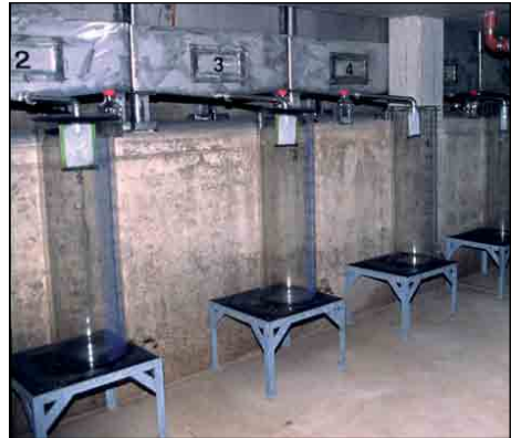
Abbildung 3: Blick in den Lysimeterkeller
