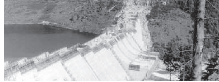
Bauzustand beim Probestau 1981
