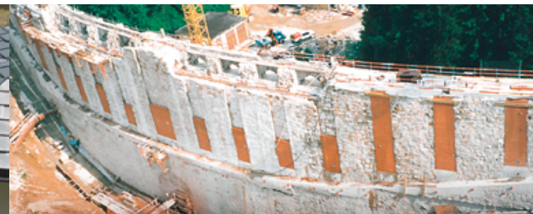
Abbruch der Mauerkrone und Ausmauerung der alten Schutzmantelnischen 1998
