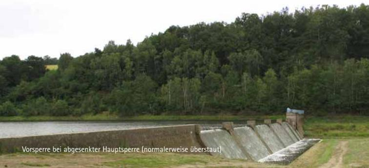
Vorsperre bei abgesenkter Hauptsperre (normalerweise überstaut)
