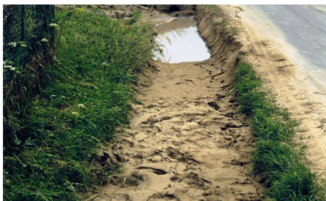
Bodenablagerung im Straßengraben
