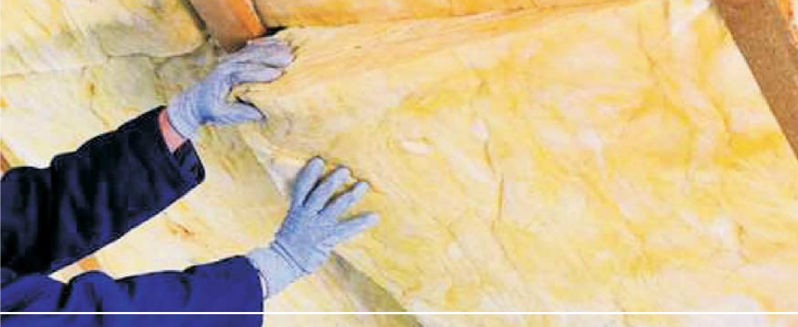
Einbau „neuer“ Mineralwollprodukte zur Dämmung
