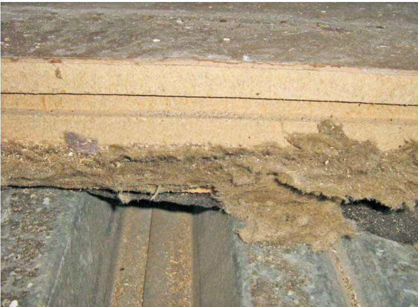
Verwendung von KMF im Bauwesen
