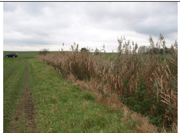
Binnengraben im Einzugsgebiet des Schnellbachs; aufgrund der starken Verschilfung ist die Vorflut nicht mehr gewährleistet
