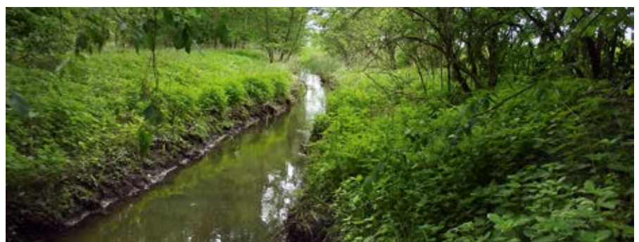
Abbildung 29: Der Gewässerabschnitt 22 a ist auch begradigt, zeigt aber bereits gute strukturelle Ansätze. Aufgrund des relativ geringen Konfliktpotenzials mit anderen Nutzungen kann er zu einem Strahlursprung entwickelt werden.
