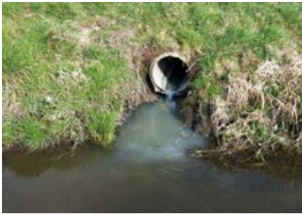
Abbildung 3: Abwassereinleitung in die Lossa
