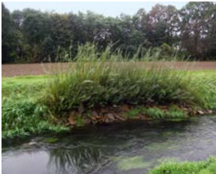
Abbildung 23: Austrieb Stechhölzer ( Salix spec. ) (oben, 1. 9. 2011) und Buschbauleitwerk zur Sicherung eines Uferabbruchs am Ende der Vegetationsperiode (unten, 10. 10. 2011)
