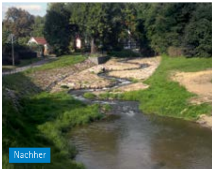
Abbildung 8: Beispielprojekt in Sachsen Gewässeraufweitung und Umbau Kirchwehr an der Pließnitz in Bernstadt
