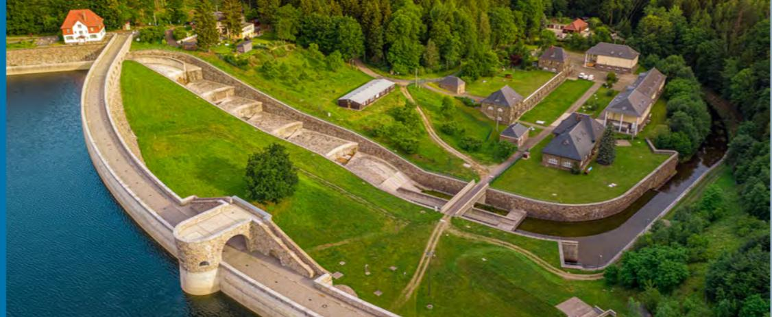
Staumauer mit Hochwasserentlastungsanlage und Entnahmeturm
