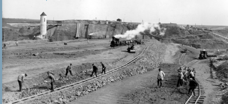
Bau der Talsperre 1929
