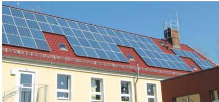
▲ Die Sonnensegel in Sachsen Verwaltung und Beratung GmbH installierte 2010 mit EU-Förderung in Höhe von rund 11.000 Euro eine Bürgersolaranlage auf dem Dach der Grundschule „Am Gickelsberg“ in Kamenz. Mit 123 Solarmodulen werden hier jährlich rund 20.250 Kilowattstunden Strom erzeugt.
