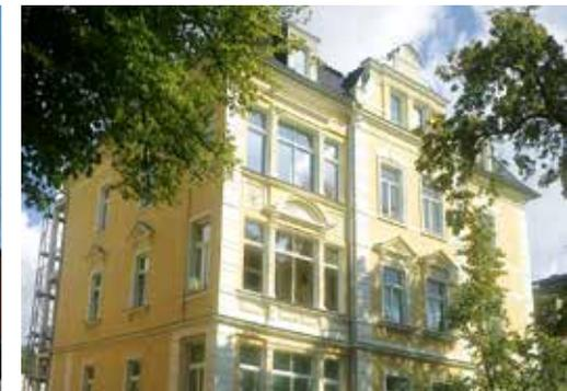
▲ Auch bei alten Gebäuden gibt es erhebliches Einsparpotenzial: In Bautzen wurde 2011 ein denkmalgeschütztes Mehrfamilienhaus – gebaut 1899 – umfassend unter Nutzung von Passivhauskomponenten energetisch saniert. Da besonders die Fassade unter Schutz steht, wurden die Außenwände von innen gedämmt. Mit den durchgeführten Maßnahmen gelang es, den Heizenergiebedarf nahezu um das Zehnfache zu senken.
