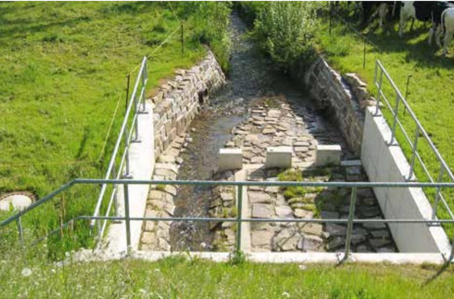
▲ Seit 2010 gibt es zwischen dem Abzweig Mühlberg und der alten Eisenbahntrasse an der Rottluffer Straße in Chemnitz Rottluff ein Hochwasserrückhaltebecken. Nur wenn der Rabensteiner Dorfbach Hochwasser führt, wird der im Dammbauwerk befindliche Durchlass wirksam und sorgt für die Reduzierung der abfließenden Wassermengen. Rund 10.000 Einwohner und ca. 30 Unternehmen profitieren im Hochwasserfall davon. 836.666 Euro betragen die Kosten, wovon aus dem EFRE ca. 570.000 Euro getragen wurden.
