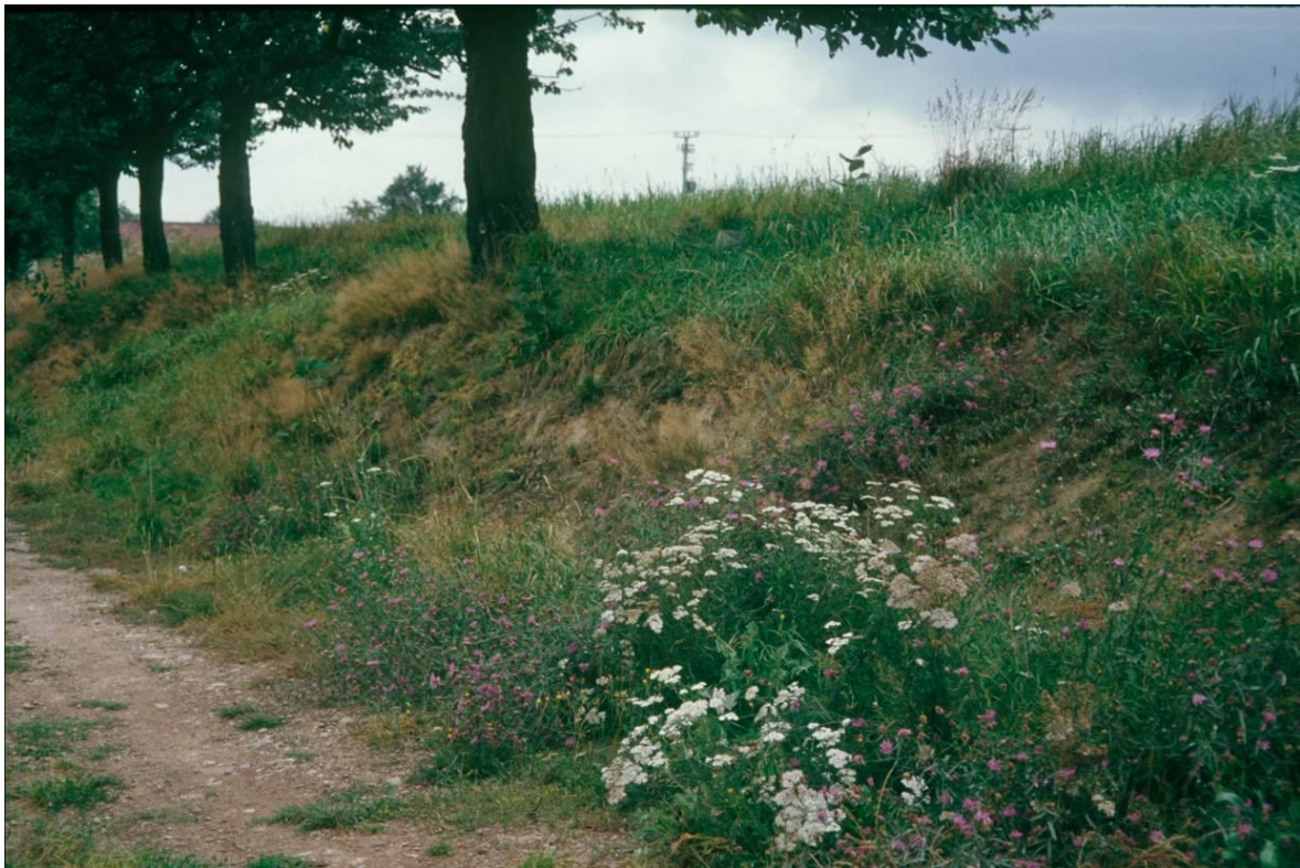
Abbildung 63: Hohlweg mit Abbrüchen bei Grumbach/Kesselsdorf
