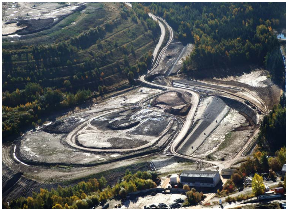
1) Blick auf die Spülhalde 1
