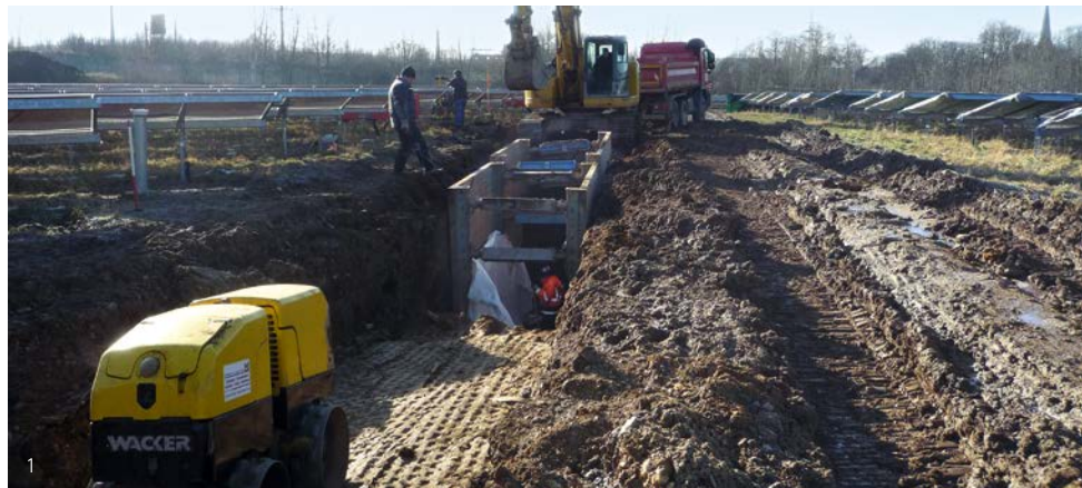
1) Bau der Infiltrationsrigole
