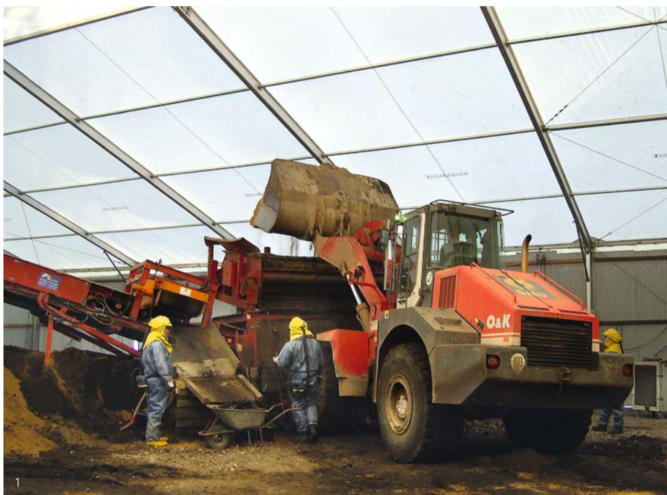
1) Das Haldenmaterial wurde gesiebt und mit Hilfe eines Magnetabscheiders von Munitionsresten befreit.
