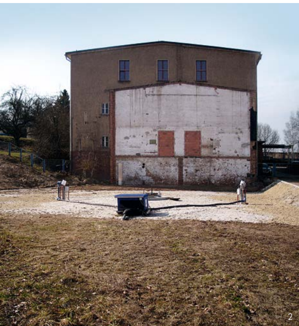
2) Fördermessstellen im Sickerbrunnen; 3) Herstellung des Sickerbrunnens im Inneren der Betonpfahlwand; 4) ehemalige Hartverchromerei
