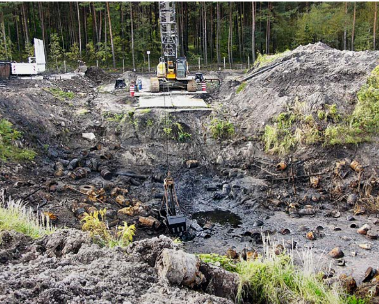
3) Restloch bei der Sumpfung, Arbeiten mit dem Seilzugbagger
