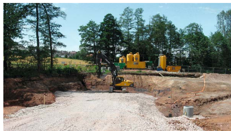
Abbildung 11: Steinkohlenmahlwerk Hohendorf; Beginn des Einbaus der Ausgleichs- und Dränageschicht, Wasserreinigungsanlage
