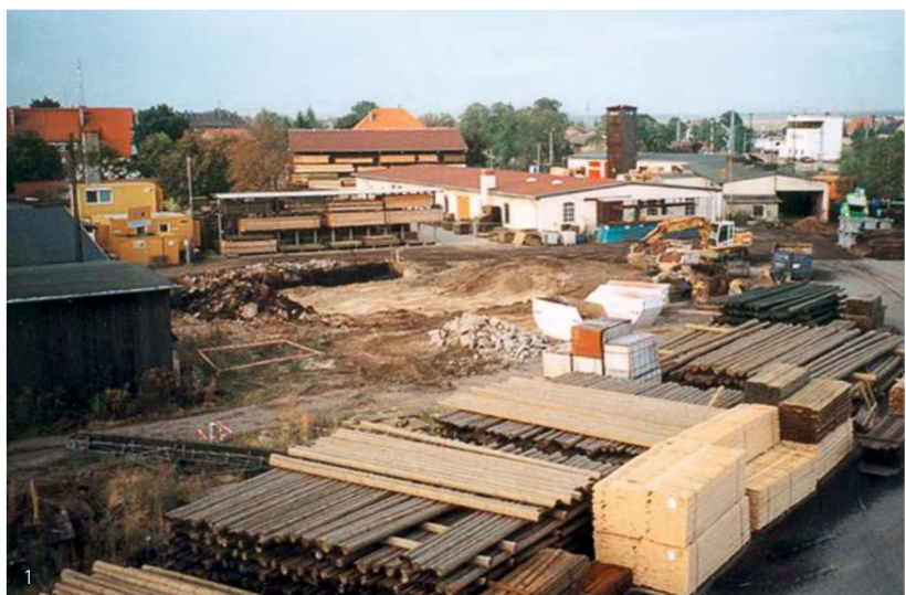
1) Sanierung bei laufender Produktion
