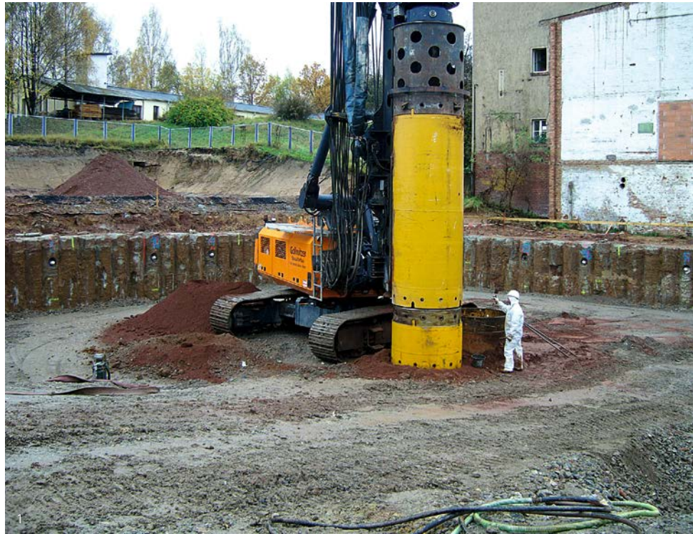
1) Großlochbohrungen innerhalb der Betonpfahlwand
