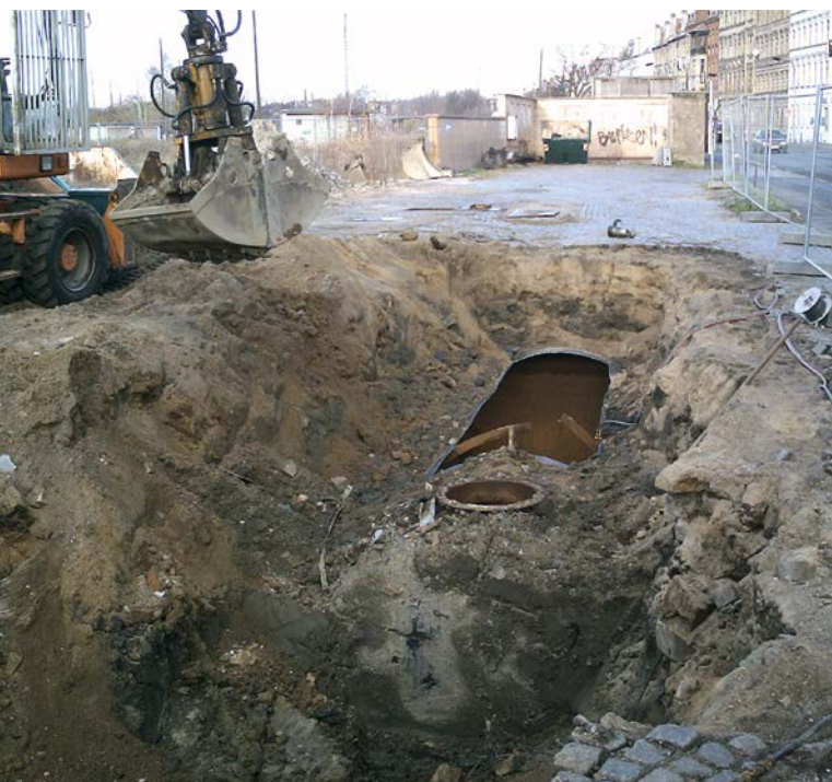
Abbildung 1: Tankberäumung im Rahmen einer Bodensanierung
