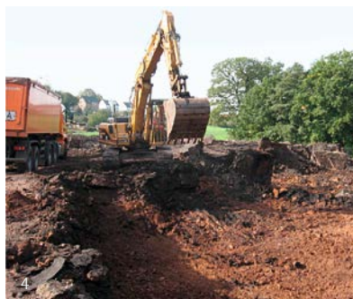
3) Steinkohlenmahlwerk – Trockenrömel mit Rauchreinigung; 4) Aushub und Abtransport des kontaminierten Materials; 5) Fund einer fünf Zentner schweren Fliegerbombe; 6) Sanierte Aschedeponie mit Weg, Entwässerungsgraben, Drainageschächten
