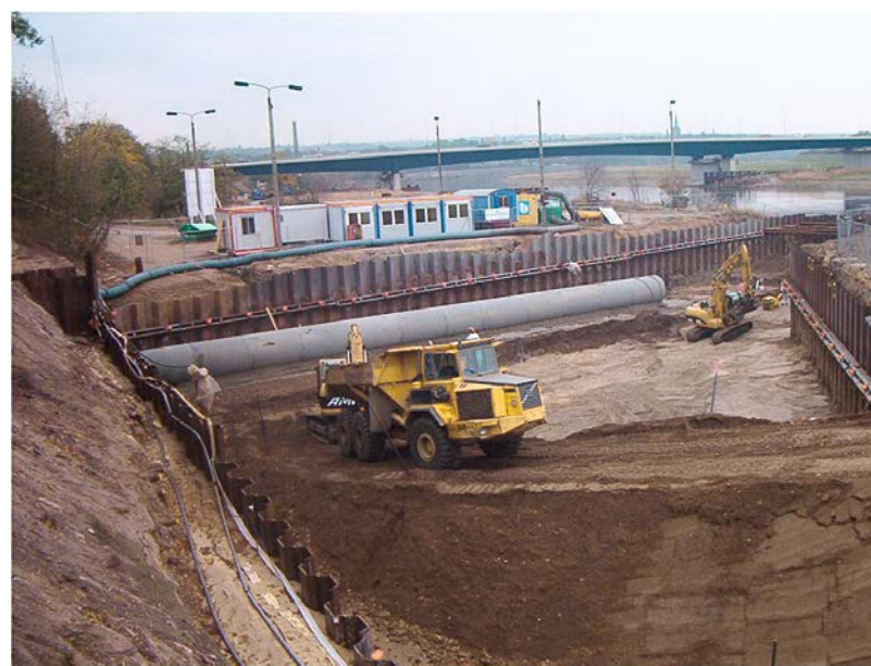
Abbildung 6: Bodensanierung an einem Tanklager mit Bauwasserhaltung in Dresden im Elbuferbereich
