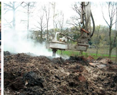
2) Einmischen von Asche in das aufgeweichte Material
