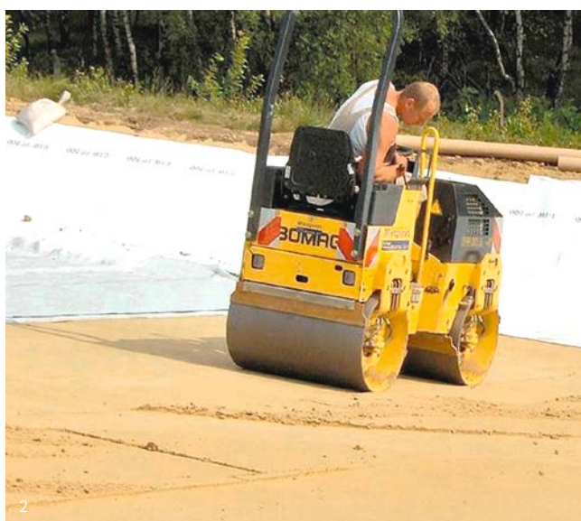
2) Sicherung der Abbrandhalde mit TRISOPLAST® als Dichtbaustoff
