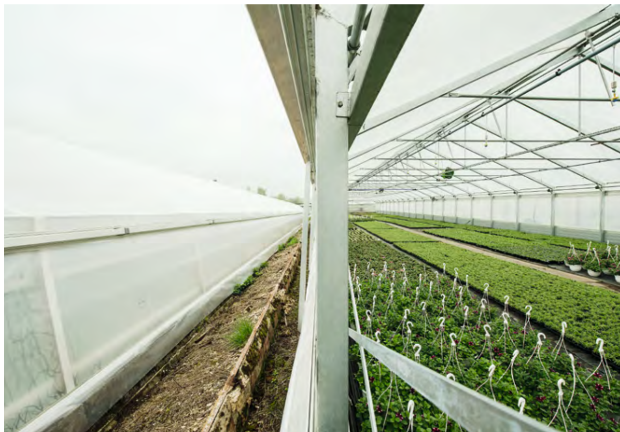
Um- und Neubau energiesparender Gewächshäuser
