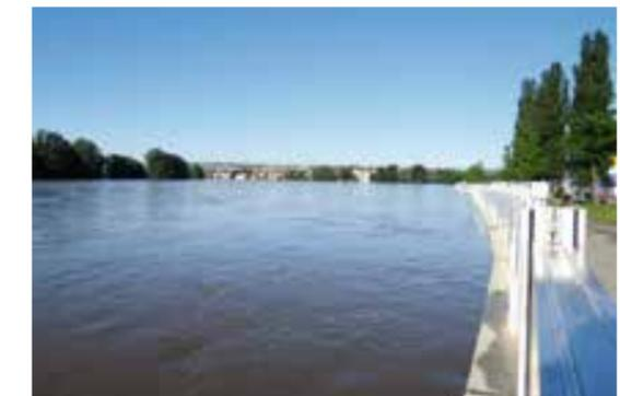
Abbildung 64: Mobile Hochwasserschutzwände während des Hochwassers 2013 in Dresden-Pieschen.
