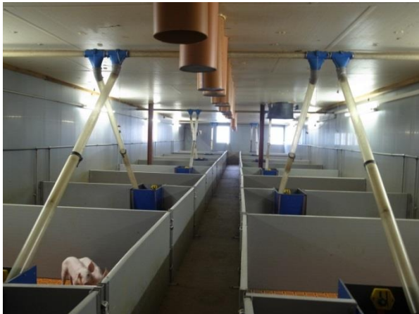
Abbildung 21: Zuluftführung (links: Stall 4; rechts: Stall 2)
