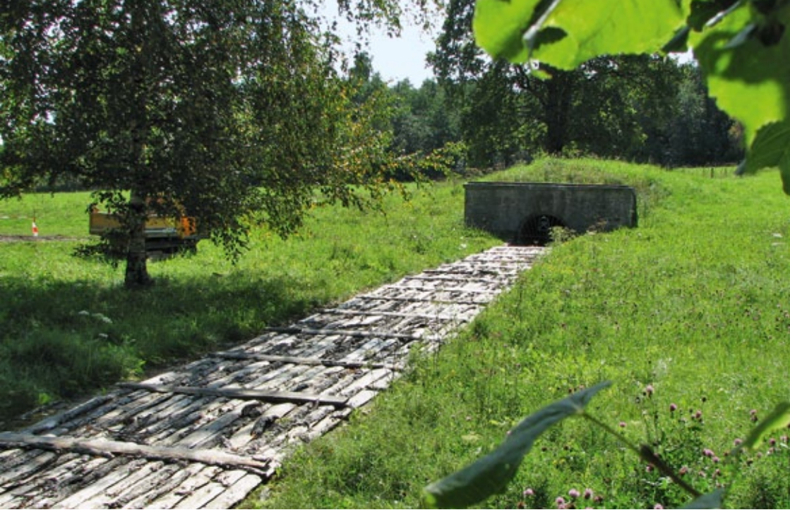
Abbildung 11: Die Bergwerksteiche des Erzgebirges sind über ein Kunstgraben- und Röschensystem miteinander verbunden. Abgebildet ist ein mit Holzbohlen abgedeckter Kunstgraben, mit Mundloch und anschließender Rösche. Foto: H. John
