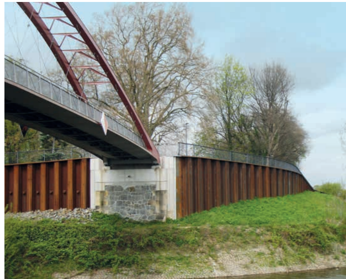
Hochwasserschutzwand im Bereich Schlossbrücke
