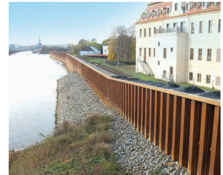
Hochwasserschutzwand im Hafen Riesa
