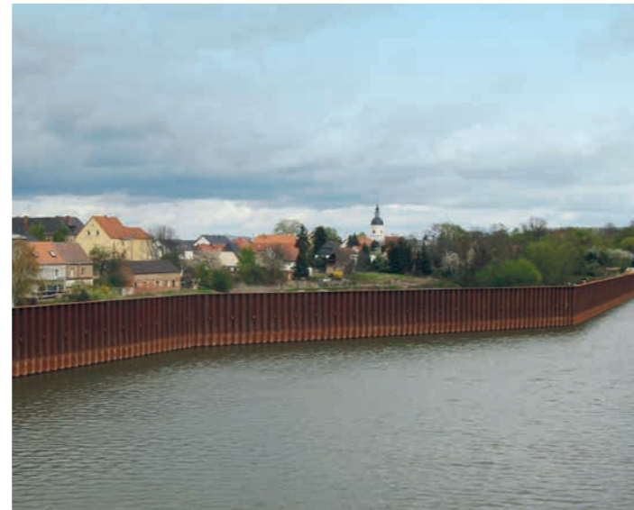
Hochwasserschutzwand im Bereich des Hafens
