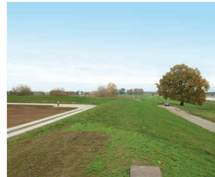
Deichneubau an der Elbe
