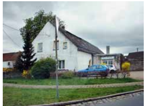
Objekt in Torgau, Ortsteil Staupitz.
