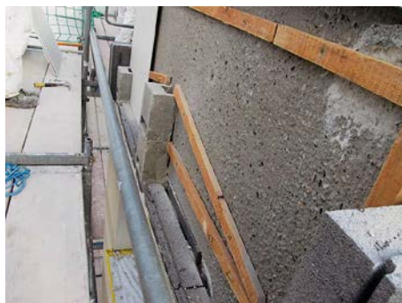
Fledermauskasten hinter der Dämmung mit Einbausteinen als Einschlupf Foto: Thomas Frank
