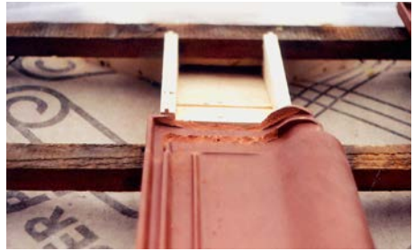
Dachstein mit entferntem Wasserfalz ermöglicht Einschluß. | Foto: Joachim Frömert
