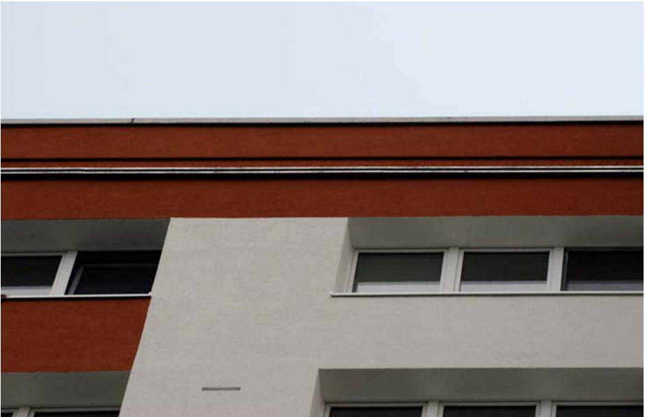
Doppelwandige Attikaverkleidung an einem sanierten Plattenbau Foto: Thomas Frank
