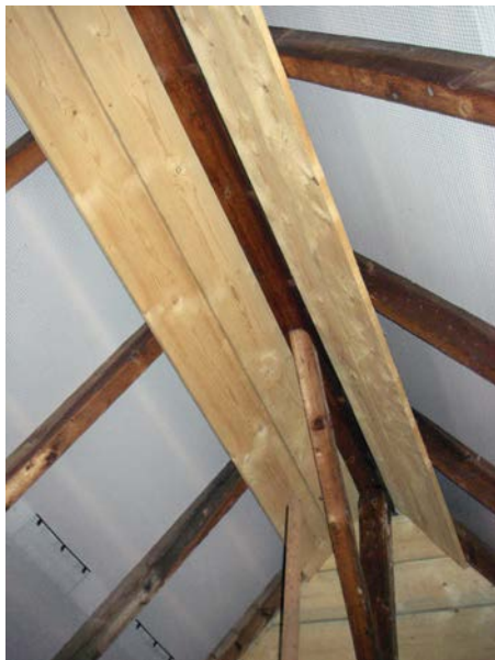
Hangplätze im First des Dachbodens eines Mehrfamilienhauses. Der Dachstuhl wurde von einer Wochenstubenkolonie des Großen Mausohrs genutzt und nach der Sanierung und dem Einbau der Hangplatzmöglichkeiten wieder besiedelt. | Foto: Thomas Frank
