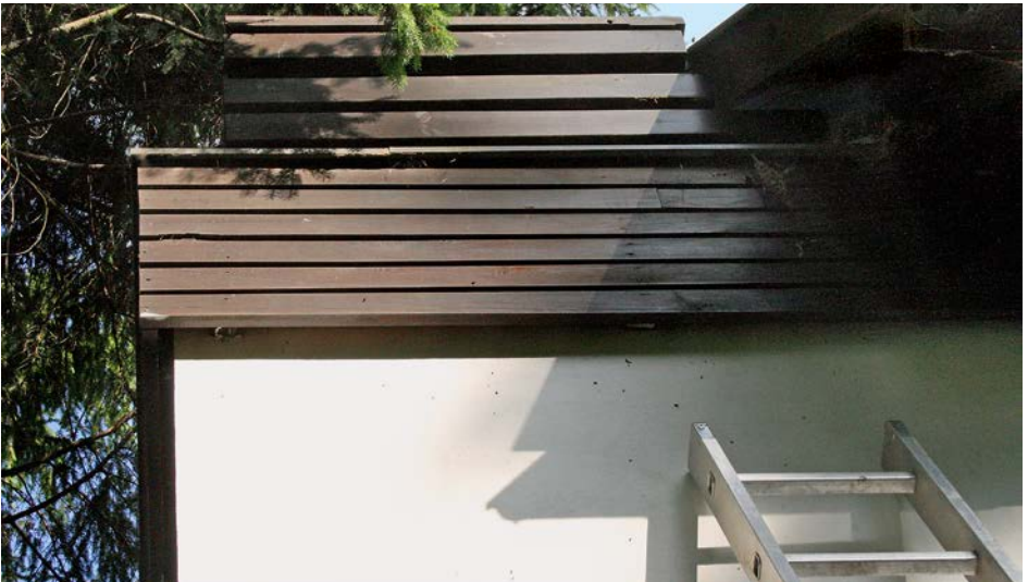
Quartier der Mopsfledermaus hinter einer Holzblende | Foto: Ulrich Zöphel
