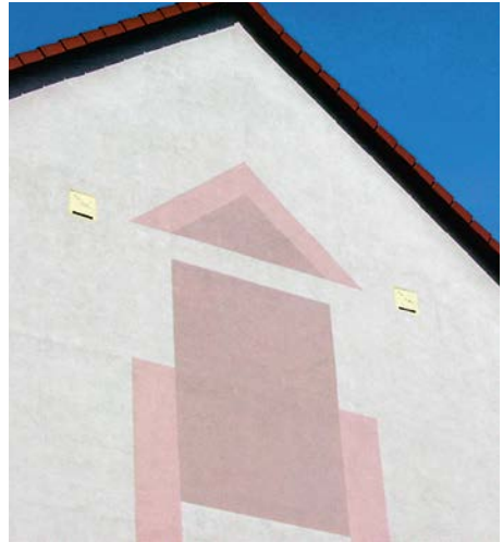
Sanierter Plattenbau in Borna mit zwei Quartiersteinen im oberen Teil der fensterlosen Giebelseite Foto: Frank Meisel
