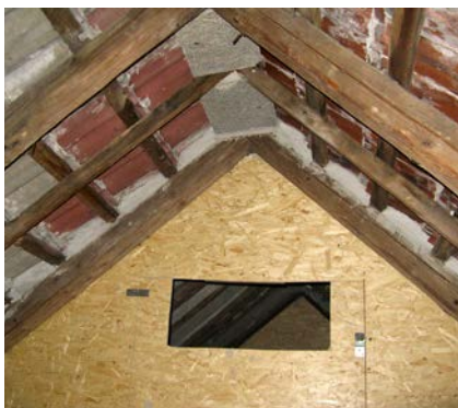
Warmer und dunkler Hangplatz (Wärmekammer) für Kleine Hufeisennasen in einem Dachboden Foto: Frank Meisel
