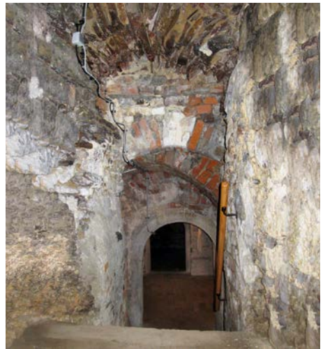
Winterquartier in einem Kellergewölbe in Torgau Foto: Bianka Schubert
