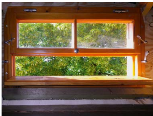
Einflugsöffnung in ein Wochenstubenquartier der Kleinen Hufeisennase | Foto: Thomas Frank
