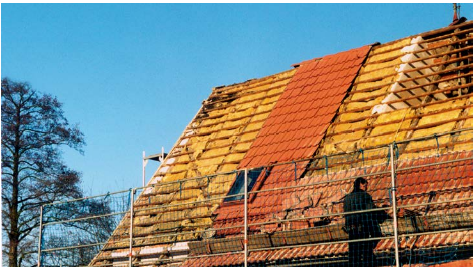
In diesem Wohnhaus im Chemnitzer Land wurde ein Quartier der Breitflügelgedermäuse unter der Dachhaut im Verlauf der Sanierung erhalten und anschließend von den Tieren wieder bezogen. | Foto: Joachim Frömert
