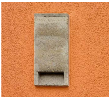
In die Dämmung integrierte Fassadenröhre Foto: Frank Meisel
