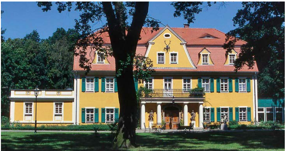
Im Fledermausschloss Weißig, einem Landgasthof im Biosphärenreservat Oberlausitzer Heide und Teichlandschaft, wurden die zahlreichen Fensterläden als Fledermausquartiere erhalten und nach erfolgter Sanierung wieder angenommen. Mit etwas Geduld lassen sich hier im Sommer Große Bartfledermäuse beim Ausflug beobachten.
