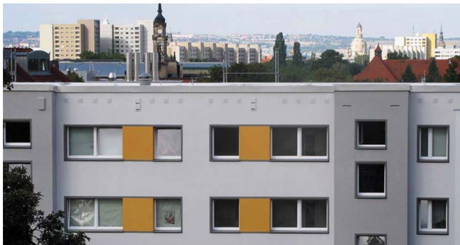
Gebäude in Dresden-Blasewitz nach der Sanierung | Foto: Thomas Frank
