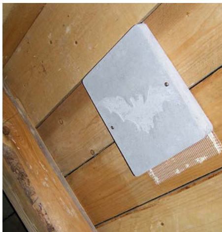
An Balken oder der Dachschalung angebrachte Wand-schalen aus Holzbeton, die im Fachhandel angeboten werden, können Hohlräume ersetzen. | Foto: Frank Meisel
