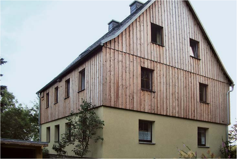
Quartier der Zweifarbfledermaus hinter einer Holzverkleidung | Foto: Thomas Frank
