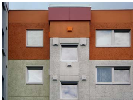
Verschiedene Quartiersteine und großräumiger Fledermauskasten am Treppenaufgang eines sanierten Plattenbaus in Dresden-Leubnitz Foto: Thomas Frank
