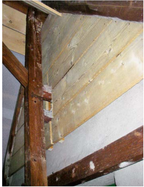
Holzverkleidung der Giebelseite | Foto: Thomas Frank
