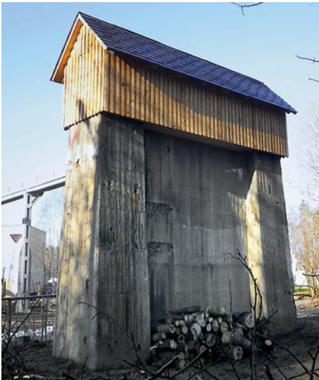
Ehemalige Kranbahn in Dresden mit fledermausgerechter Holzverkleidung | Foto: Thomas Frank
