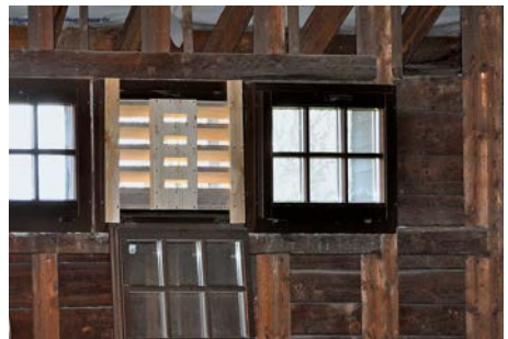
Turnhalle mit Einschlupföffnungen, die zur Marderabwehr verengt wurden. | Foto Joachim Frömert
