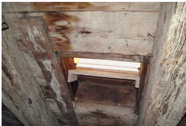
Umgestaltetes Dachflächenfenster – Ansicht von innen | Foto: Thomas Frank
