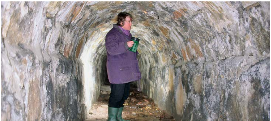
Quartierkontrolle in einem von Mopsfledermäusen bewohnten Wasserdurchlass in Mittelsachsen Foto: Elke und Reimund Francke
