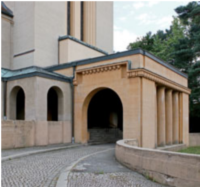
Auffahrt mit Vorhalle
