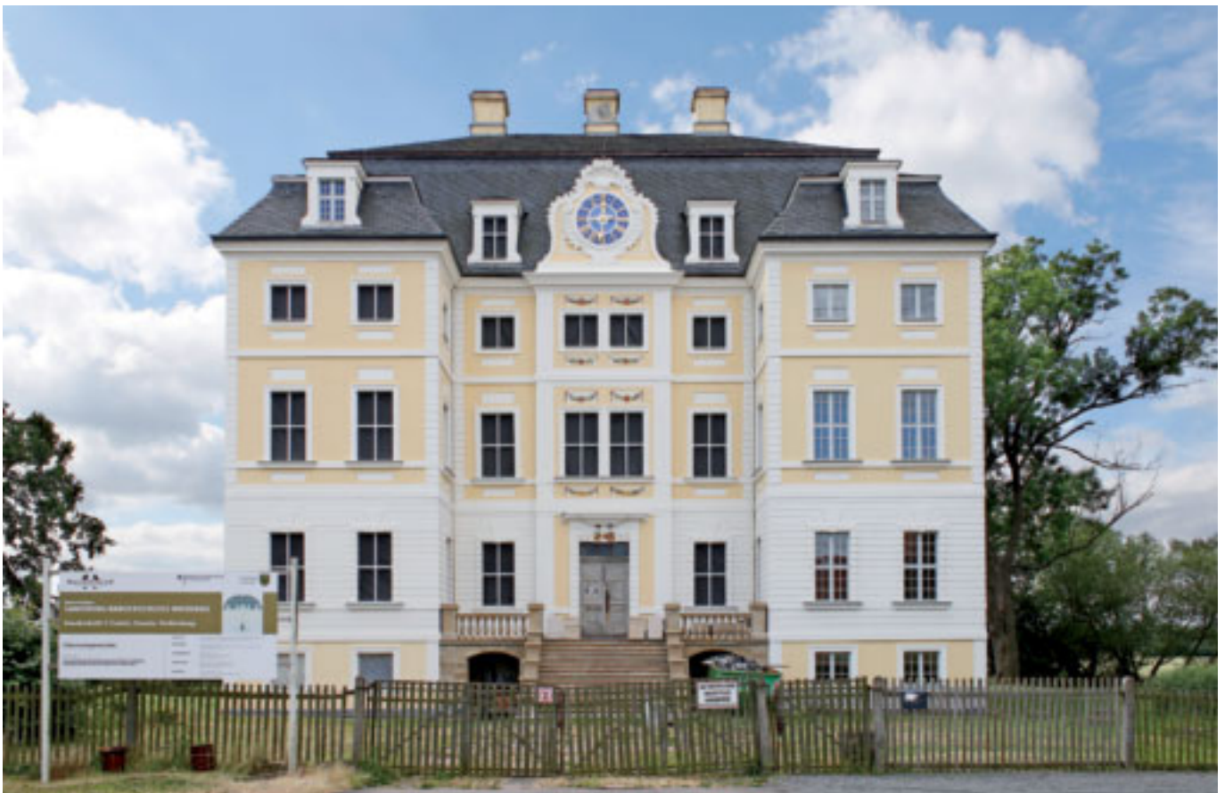
Gesamtansicht von Nord
