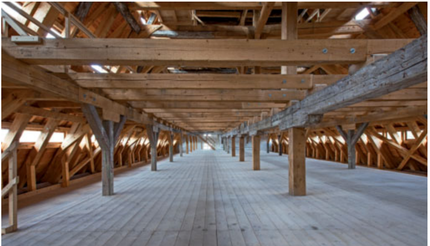
Blick in den Dachstuhl
