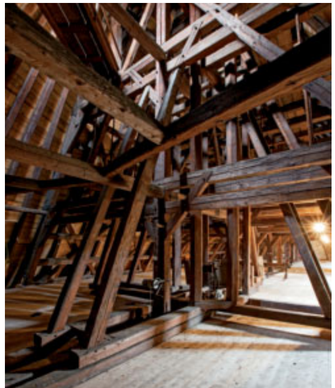
Holzkonstruktion des Dachtragwerkes
