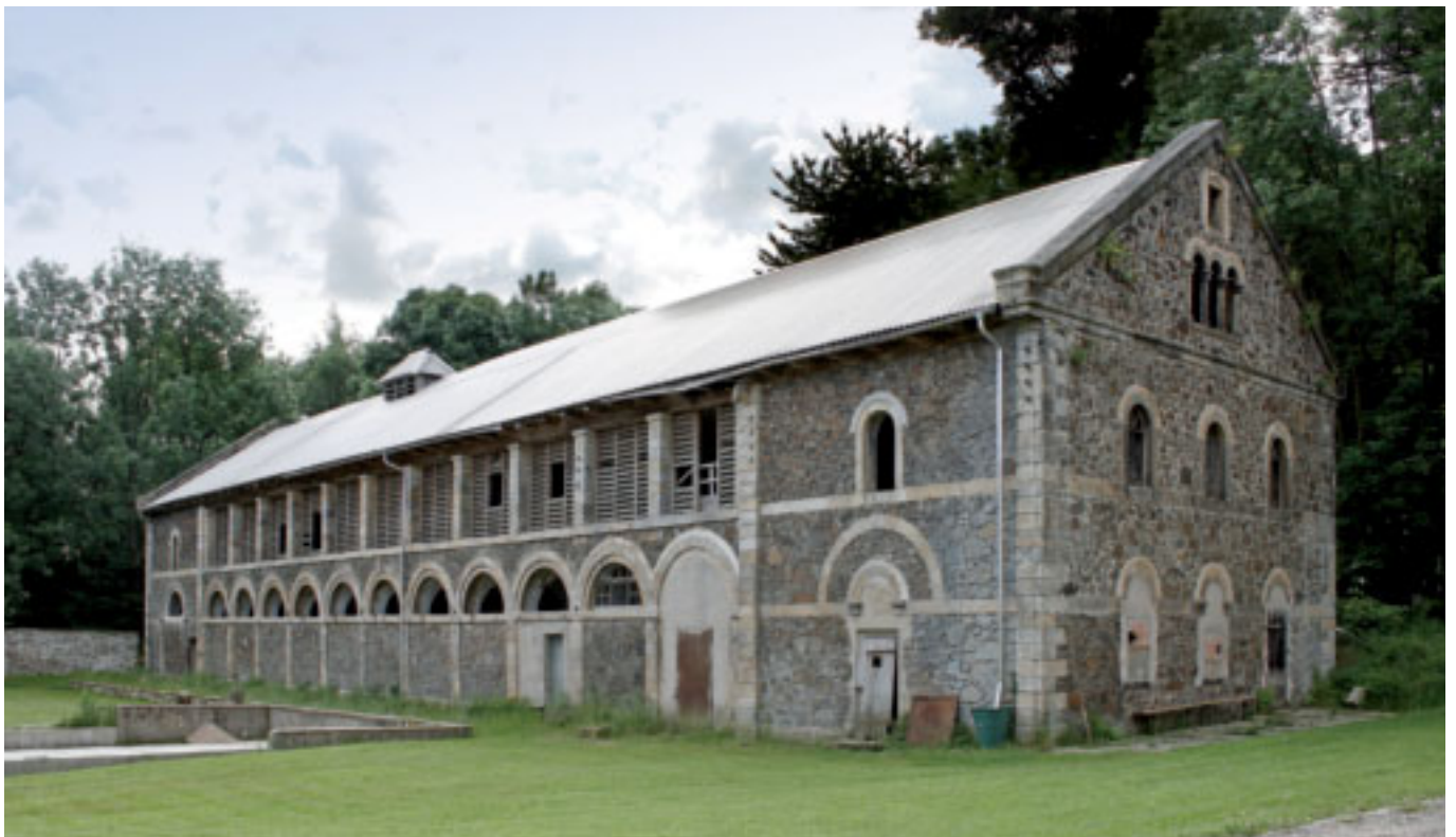
Stallgebäude, wohl von Gottfried Semper
