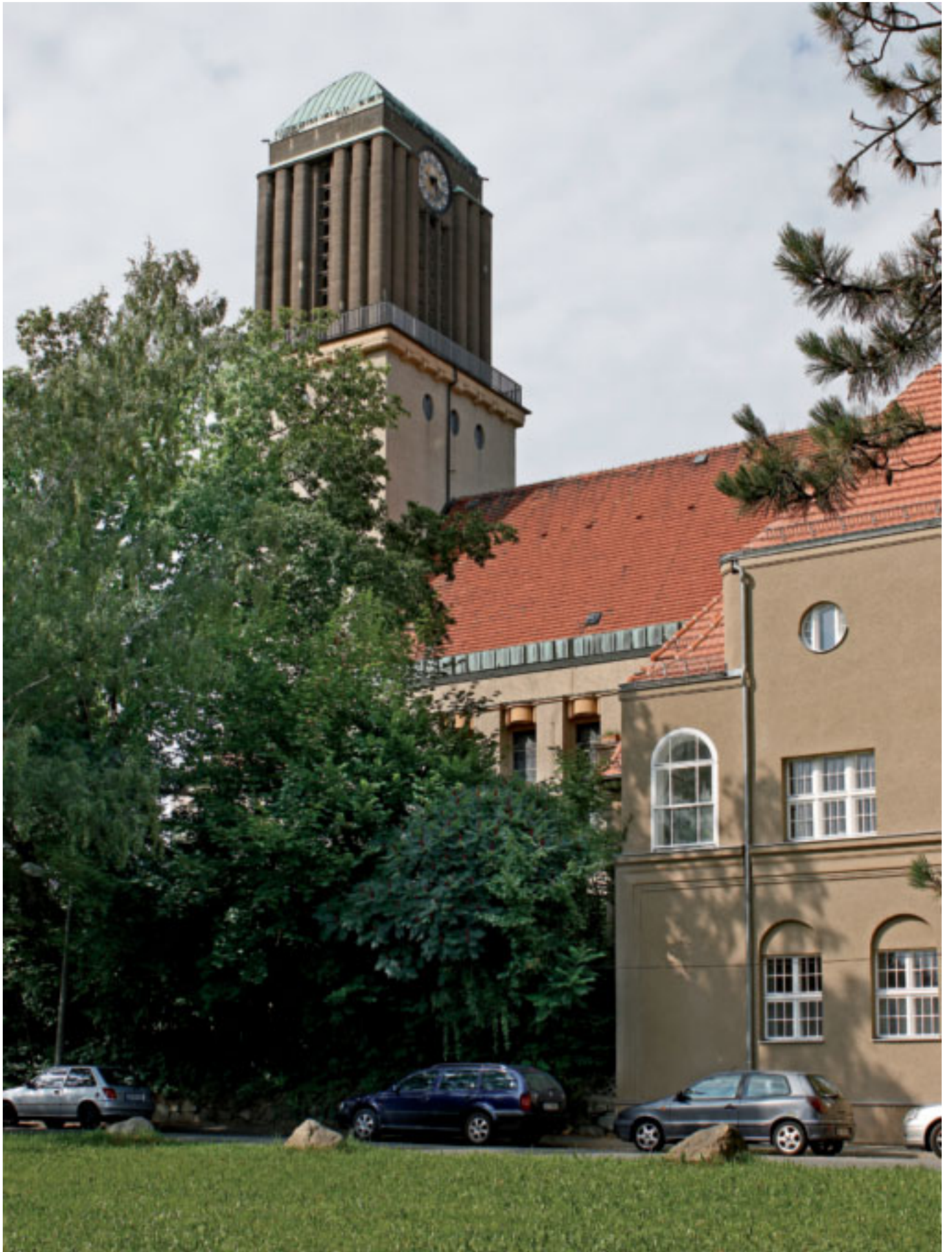
Seitenansicht mit Gemeindehaus
