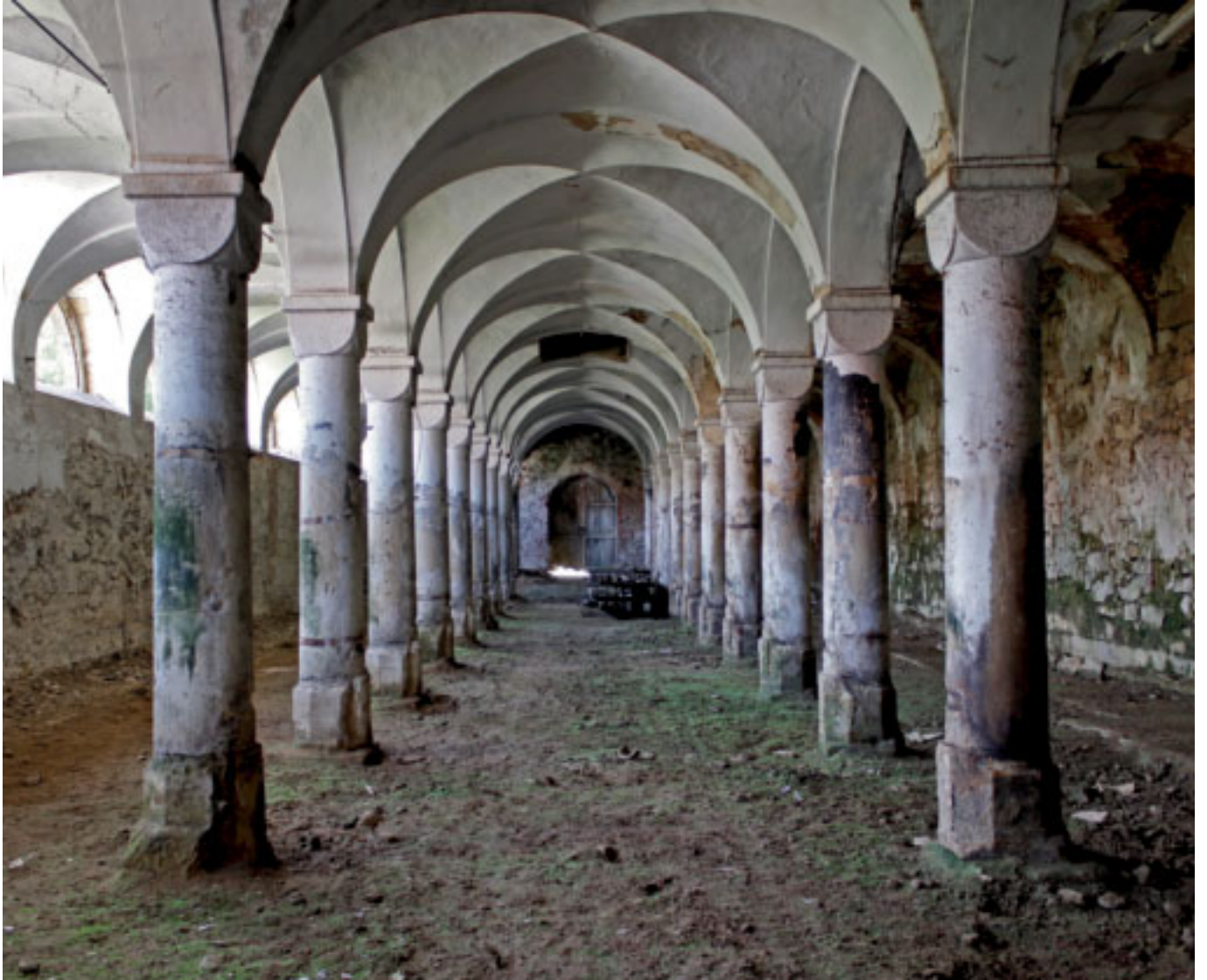
Innenansicht des dreischiffigen Stalls
