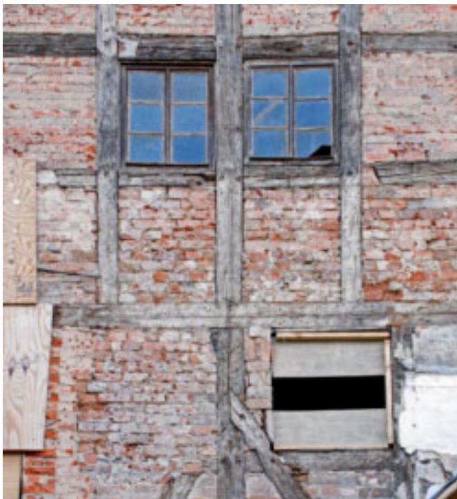
Detail der Hoffassade
