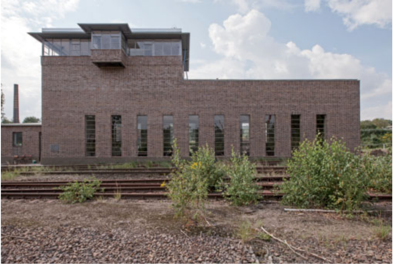
Maschinenhaus der Seilablaufanlage mit aufgesetztem Stellwerk 2
