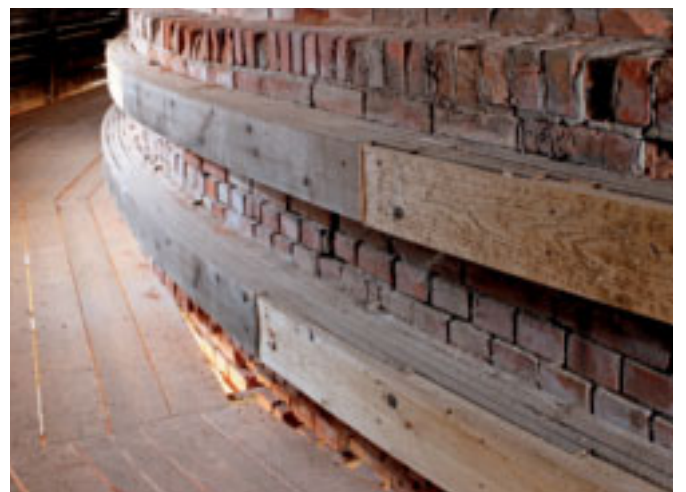
Instand gesetzte Reifenumfassung der Brennkammer
