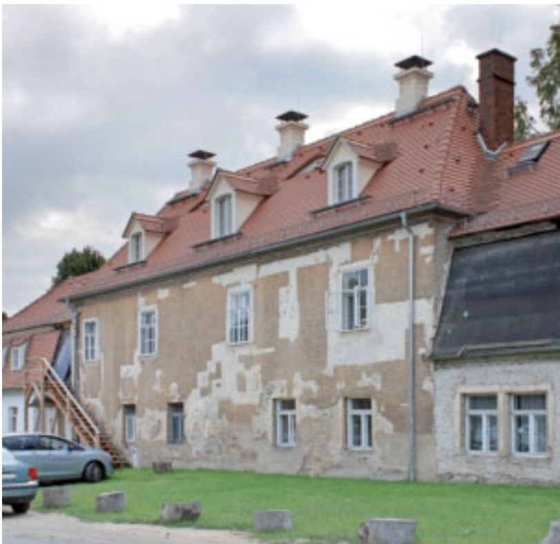
Neueindeckung der Dächer und Freilegungsproben an der Straßenfassade
