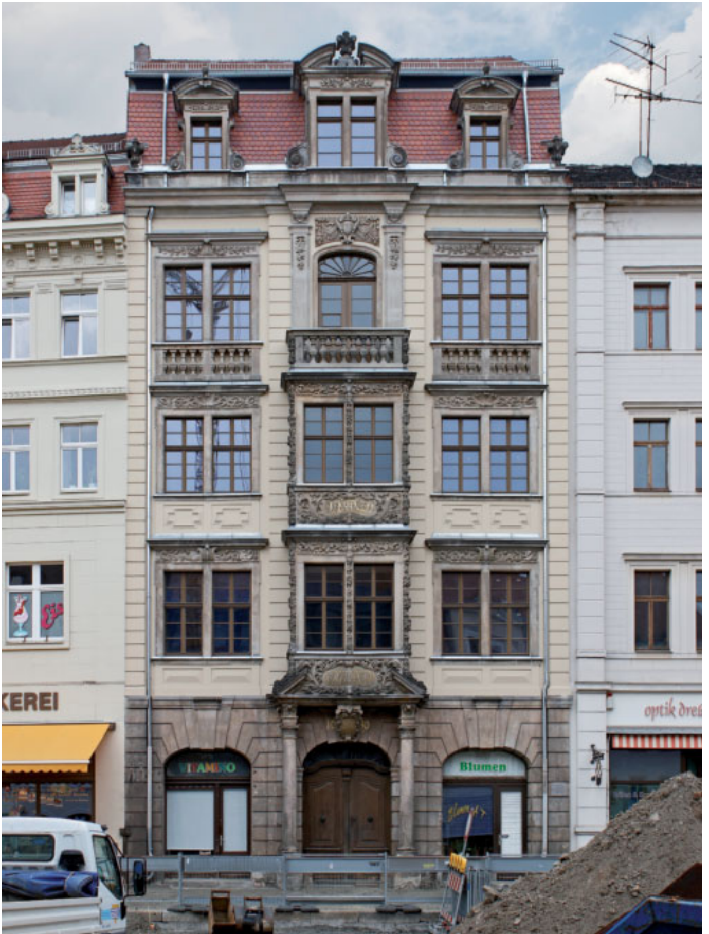
Gesamtansicht der Fassade zum Markt
