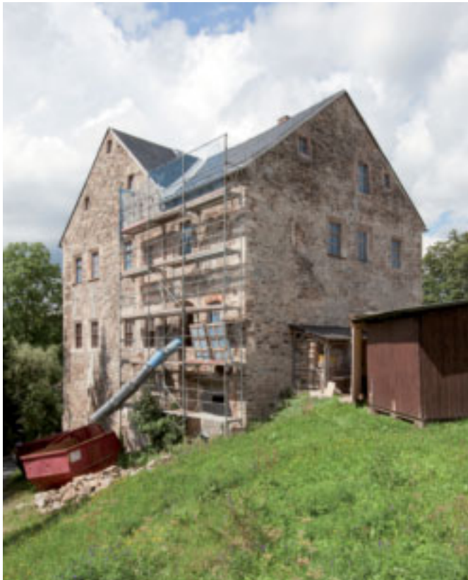
Ansicht von Südost
