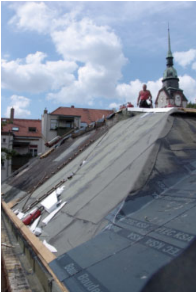
Dachpartie während der Neueindeckung 2006
