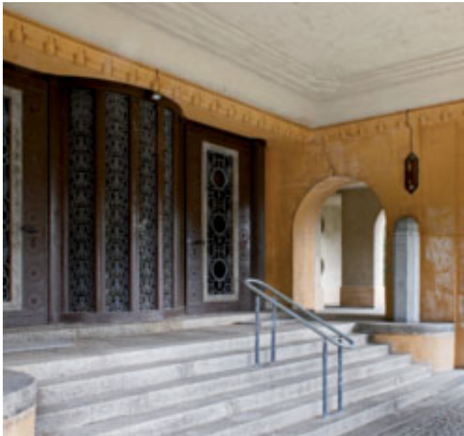
Portalsituation in der Turmfront
