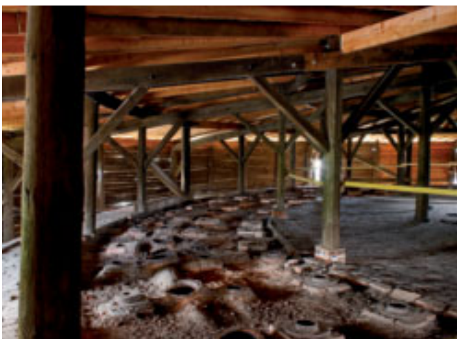
Trockenboden mit saniertem Dach
