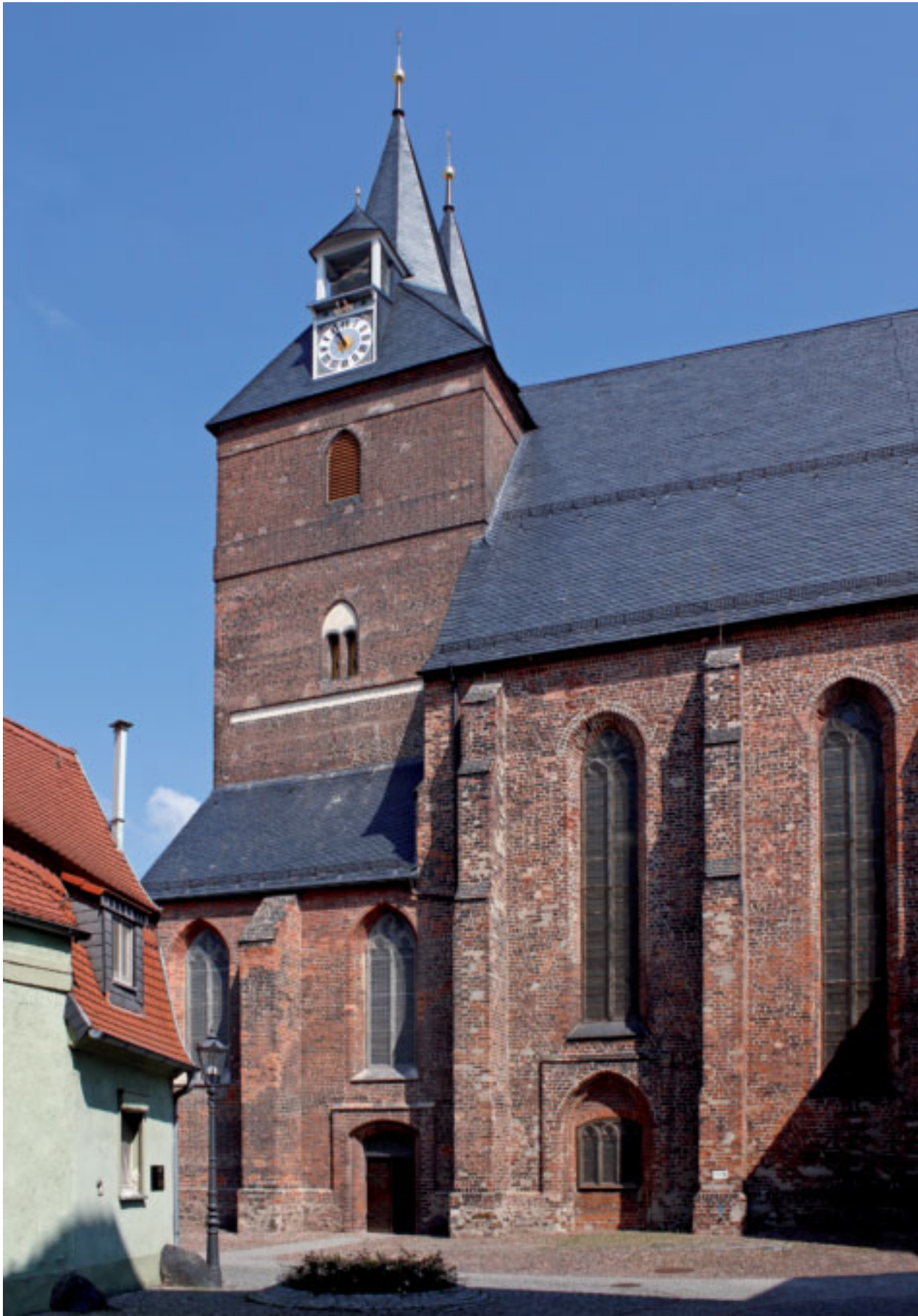
Blick auf die Südseite von Schiff und Westturmfront
