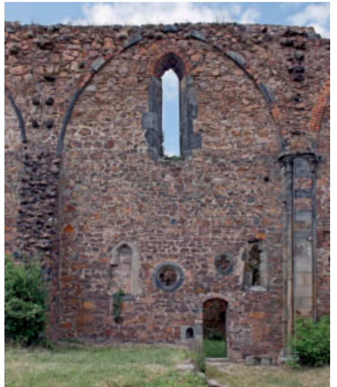
Blick auf die Abrisskante der ehemaligem Einwölbung
