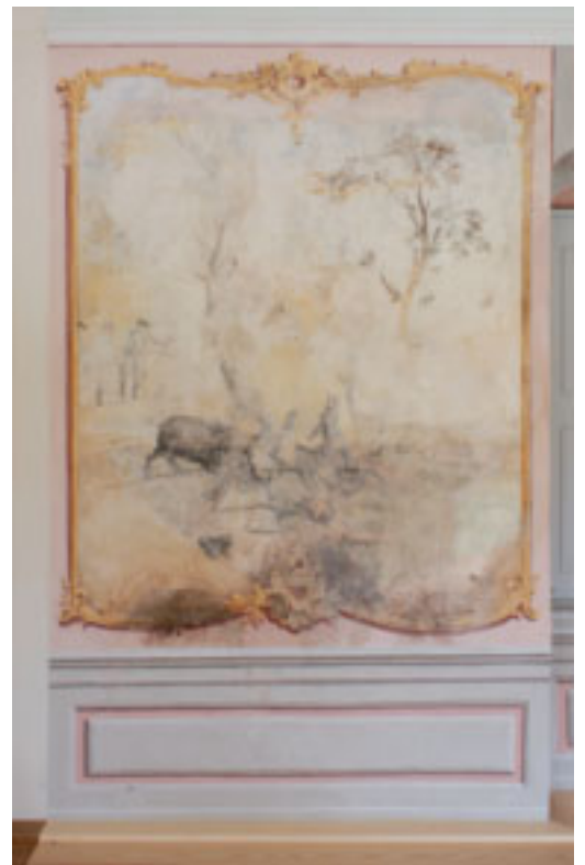
Wandbild im ersten Obergeschoss nach Freilegung
