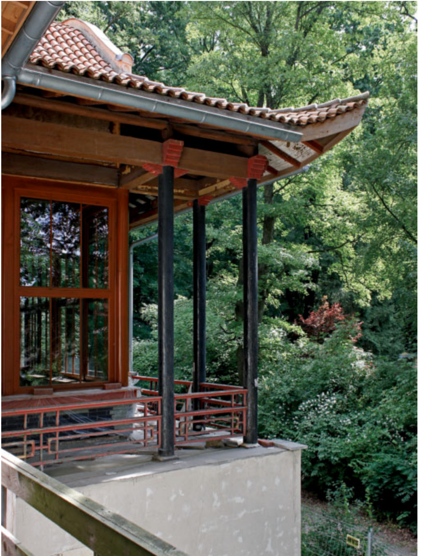
Detail während der Instandsetzungsarbeiten
