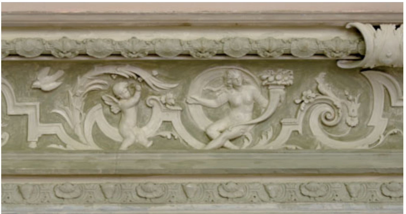
Detail einer Stuckkehle
