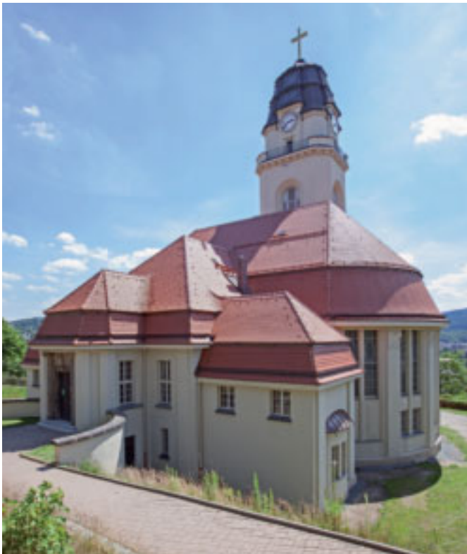
Ansicht von der Hangseite mit Dachkehlen in Biberschwanzdeckung
