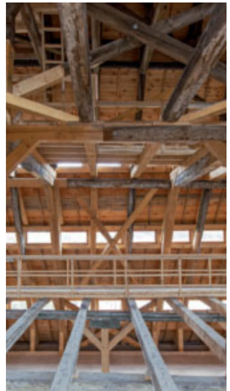
Dachtragwerk nach Ertüchtigung
