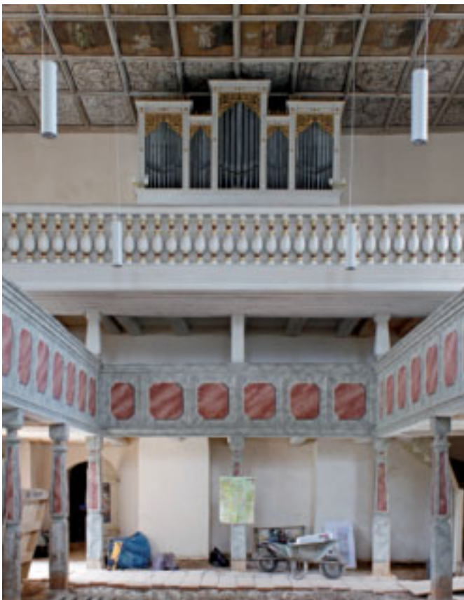
Blick zur Orgelempore während der Baumaßnahmen
