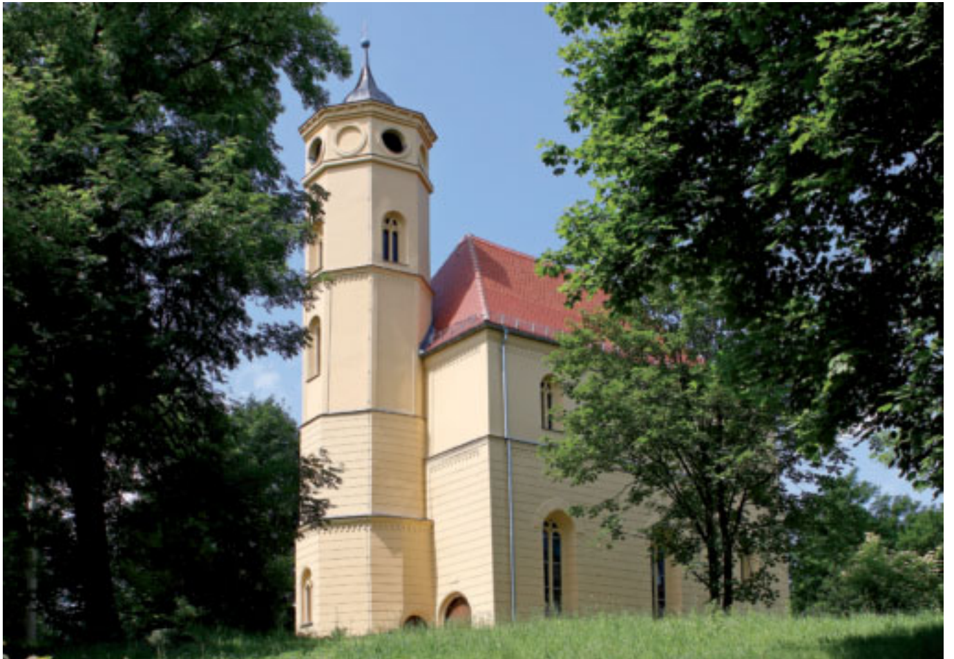
Außenansicht der Kapelle im Gutspark
