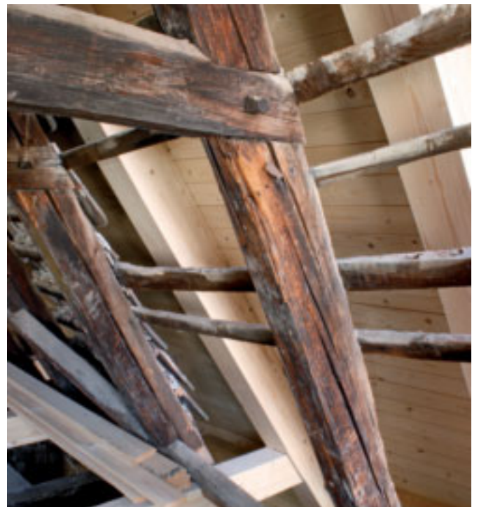
Spätgotischer Dachstuhl mit neuem Überdach, Detail
