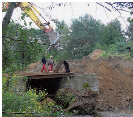
Rückbau der Panzerkettenbrücke
