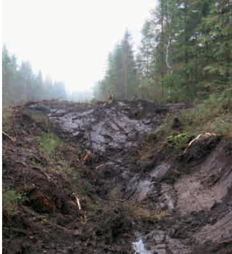
Torfdamm aus ca. 70 m<sup>3</sup> Torf kurz nach der Fertigstellung |
