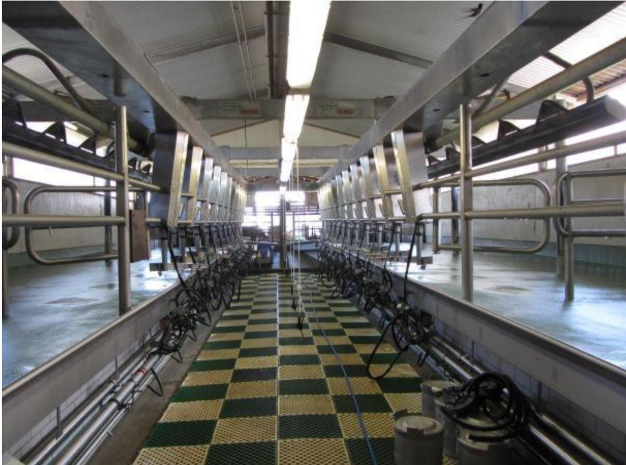
Für den Melkstand wurden die Stromverbraucher und deren tägliche Laufzeiten dokumentiert. Der Warmwasserbedarf für die Spülung wurde über vorhandene Wasserzähler ermittelt. Der zusätzliche Wasserbedarf der Euterduschen wurde mit 0,5 l/Gemelk kalkuliert.
