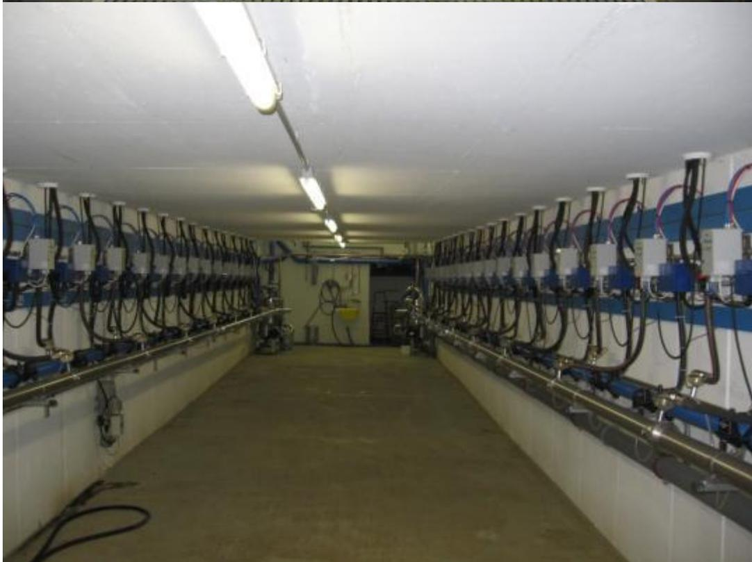
Im Untersuchungszeitraum 2010 bis 2013 wurden die elektrische Arbeit und die Wasserverbräuche im Melkprozess über Unterzähler gemessen. Die Verbraucher und deren tägliche Laufzeiten wurden dokumentiert. Die MVA verfügt über eine Biogasanlage, aus der vorgewärmtes Wasser mit etwa 55 °C in den Milchgewinnungsprozess eingespeist wird.
