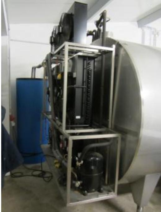
Die Auslastung der Anlage ist auf Grund des Bestandsaufbaus noch nicht im gewünschten Maß gegeben. Im ersten Messzeitraum lag die mittlere Tagesmilchmenge bei 3.929 kg, im zweiten bei 5.354 kg. Zusätzlich steht ein 1.000 l-Tank zur Überbrückung der Tankspülzeiten zur Verfügung, welcher mit einem separaten Kühlaggregat ausgestattet ist.
