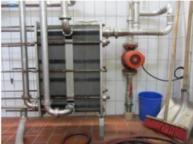
Der Kühlblock verfügt über eine Wärmerückgewinnungsanlage. Das gewonnene warme Wasser wird ebenso wie das Wasser aus dem Vorkühler für die Erwärmung des Tränkwassers genutzt. Die MVA verfügt über eine Biogasanlage. Deren Abwärme reicht aus, um sämtliches Nutzwasser ausreichend zu erwärmen.
