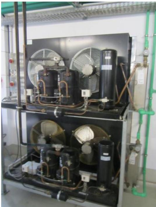
Die Anlage verfügt über eine Wärmerückgewinnung, mit der Wasser auf 53 °C erwärmt wird. An jede Aggregatekombination ist ein Wärmetauscher angeschlossen. Für die Vorkühlung der Milch vor Einlauf in den Tank sorgt ein Plattenkühler. Dieser verfügt über einen separaten Spülkreislauf.
