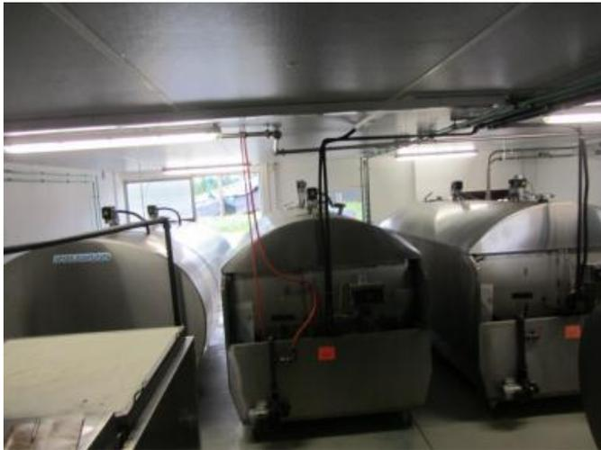
Für die Leistung der notwendigen Kältearbeit sind die Tanks jeweils mit einem Verdichtersatz mit zwei Verdichtern und zwei Kühlventilatoren ausgestattet. Die Zuluft zu den Verflüssigern wird durch Lamellenfenster in der Wand angesaugt.
