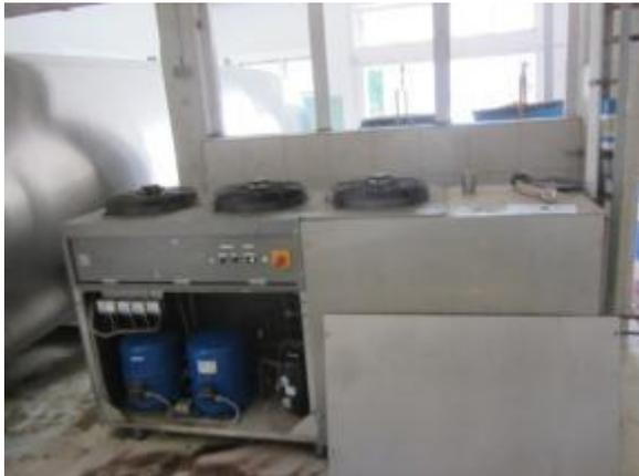
Die Anlage verfügt über einen Plattenkühler, der die Milch mit Brunnenwasser vorkühlt. Weil die Milchviehanlage über eine Biogasanlage verfügt, wurde die ehemals vorhandene Wärmerückgewinnungsanlage abgeschaltet.
