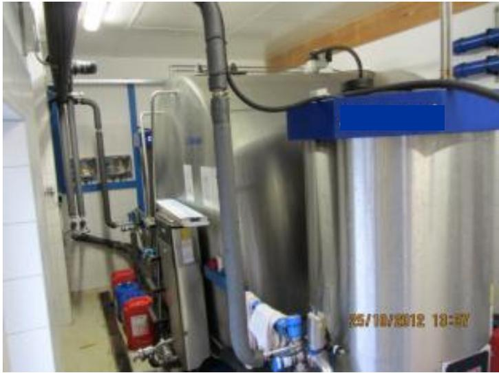
Die beiden Scrollverdichter der Kälteaggregate haben eine elektrische Anschlussleistung von 5,8 KW. Die Verflüssiger befinden sich auf der Nordseite außen am Milchhaus.
