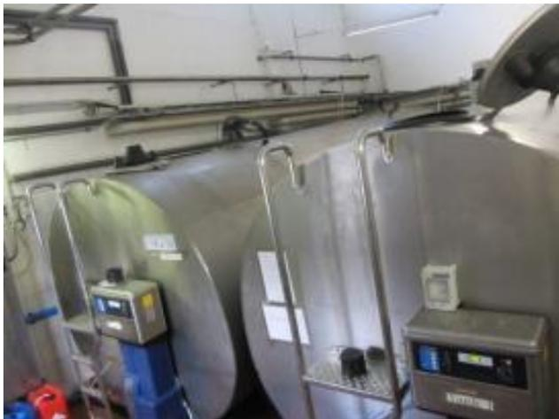
Gekühlt wird die Milch mit einer Eiswasserkühlung. Zur Eiswassererzeugung steht ein Kühlblock zur Verfügung. Er verfügt über drei Kälteaggregate mit einer elektrischen Anschlussleistung von je 11,06 KW. Der Eiswasserbehälter fasst 240 l Wasser.
