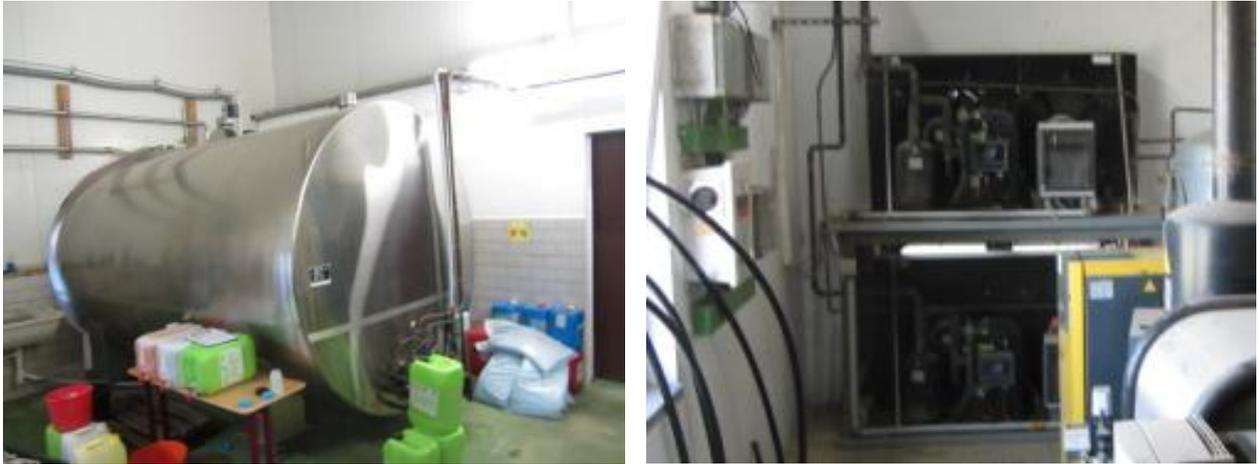
Die Anlage verfügt über eine Wärmerückgewinnung. Das auf 53 °C erwärmte Wasser wird zur Spülung und im Sanitärbereich eingesetzt. Eine Vorkühlung ist nicht vorhanden. Die Sommermessreihe zum Energiebedarf der Milchkühlung wurde im Zeitraum vom 13. bis 27.09.2013 durchgeführt. In diesem Zeitraum lagen die Tagesdurchschnittstemperaturen – gemessen am Zuluftfenster von Abholung bis Abholung – bei 11,8 °C.
