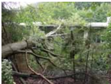
Abb. 6: Beschädigtes Gebäude nach Sturm
