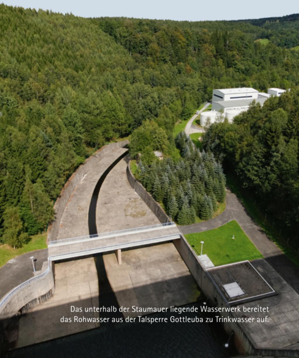
Das unterhalb der Staumauer liegende Wasserwerk bereitet das Rohwasser aus der Talsperre Gottleuba zu Trinkwasser auf.
