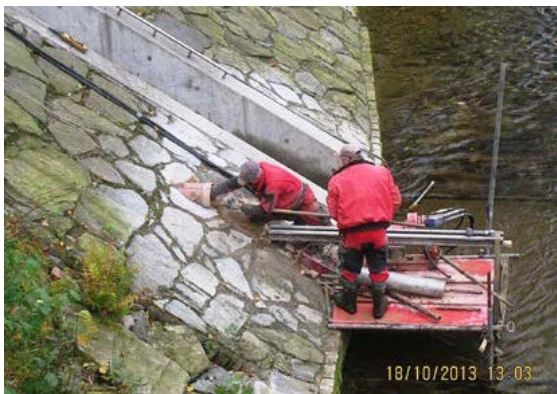
Abb. 4: Einbau zusätzliches Pegelzulaufrohr am Hochwasserpegel Mulda1
