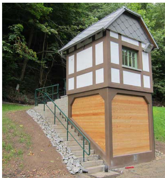
Abb. 7: Neu errichtetes Pegelhaus Rosenthal / Neißة
