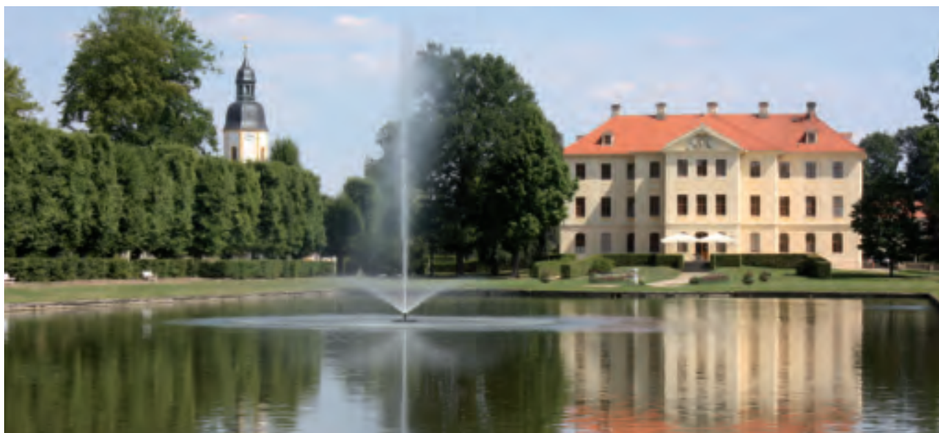
Pohled přes odrážející se vodní hladinu na palác a kostel
