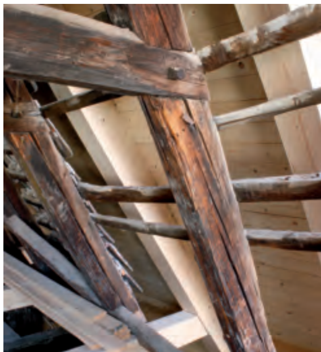
Pozdně gotický krov s novým zastřešením, detail
