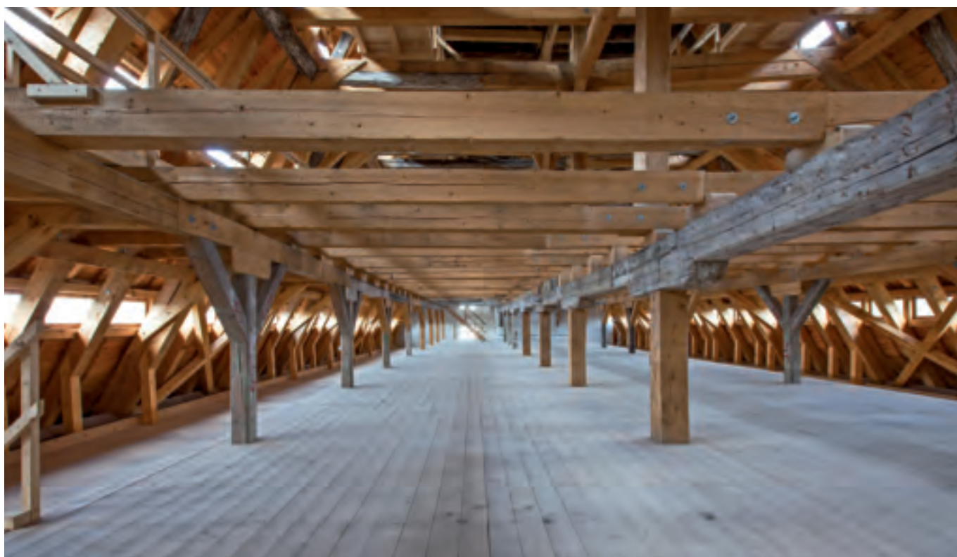
Pohled na krov
