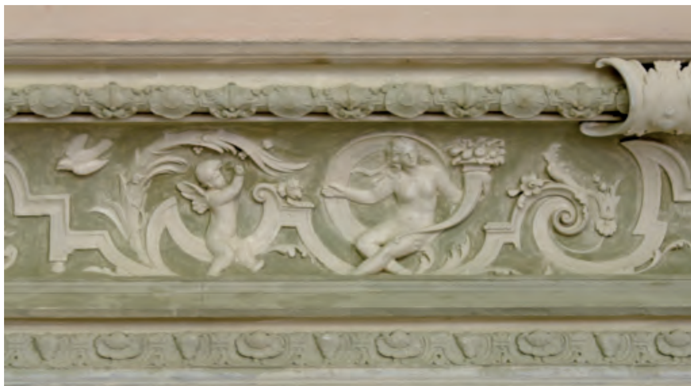
Detail štukovaného fabionu
