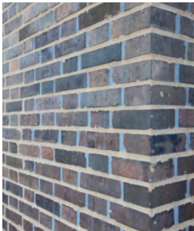
Dvoubarevné spárování typické pro dobu výstavby památky
