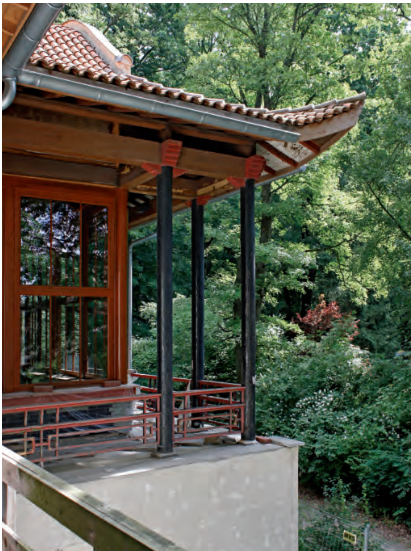
Detail během oprav
