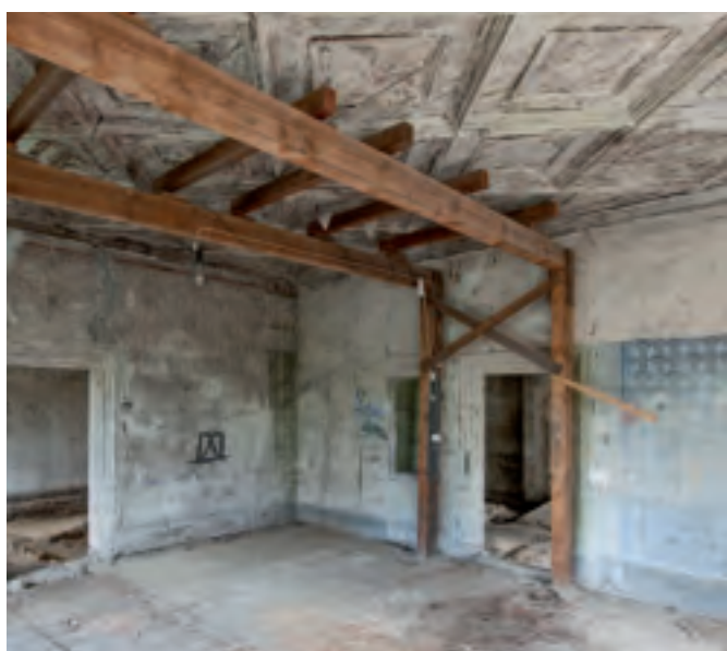
Kazetový strop v prvním podlaží
