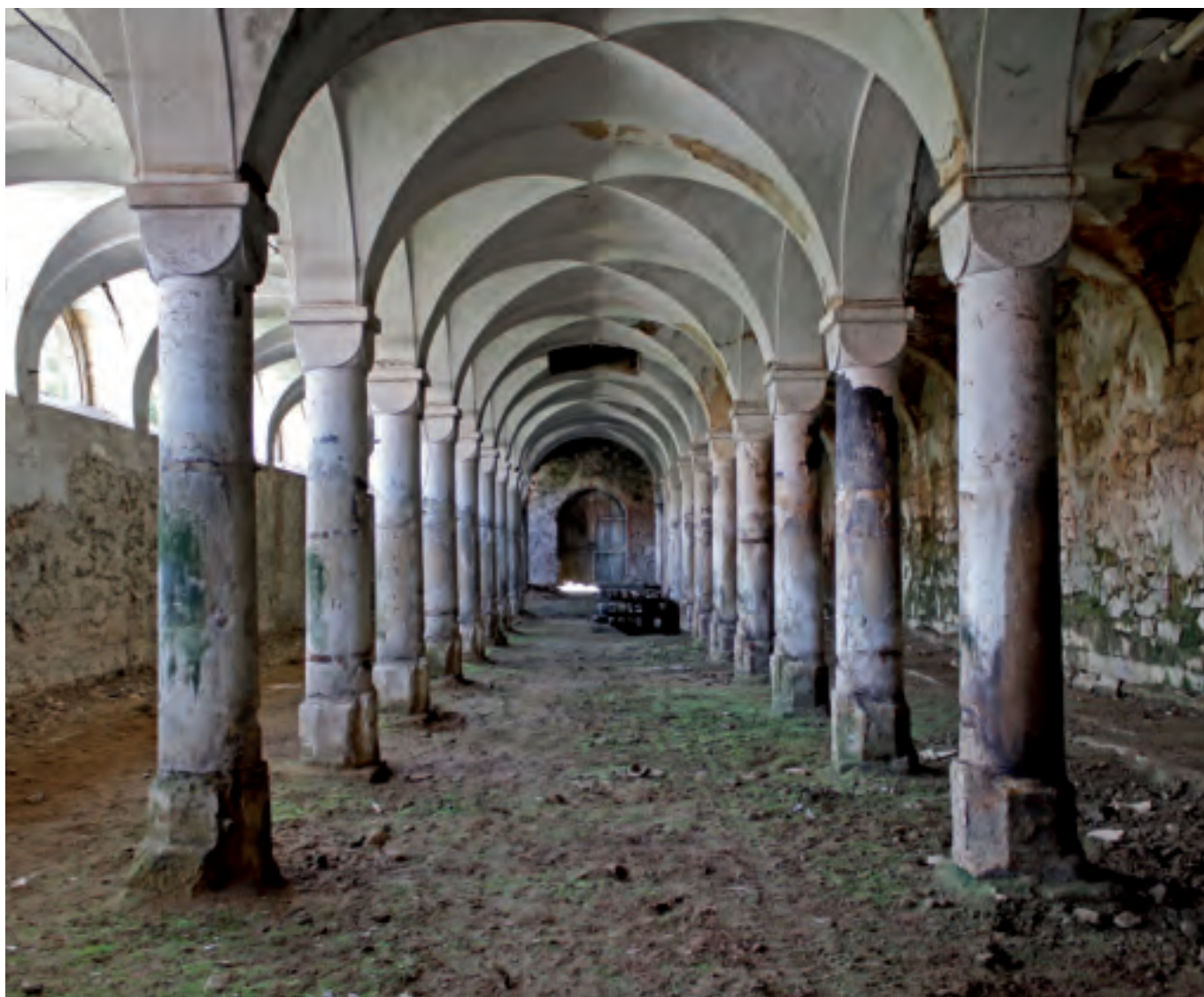
Pohled do vnitřních prostor trojlodní stáje
