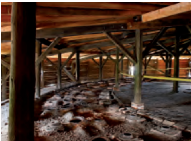
Půdní sušárna s rekonstruovanou střechou
