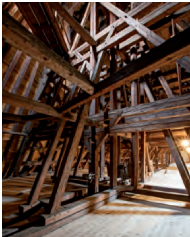
Dřevěná střešní nosná konstrukce
