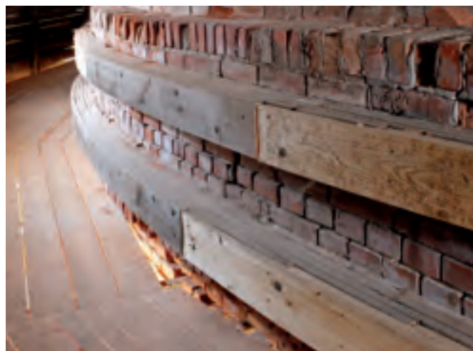
Opravené obvodové obruče spalovací komory
