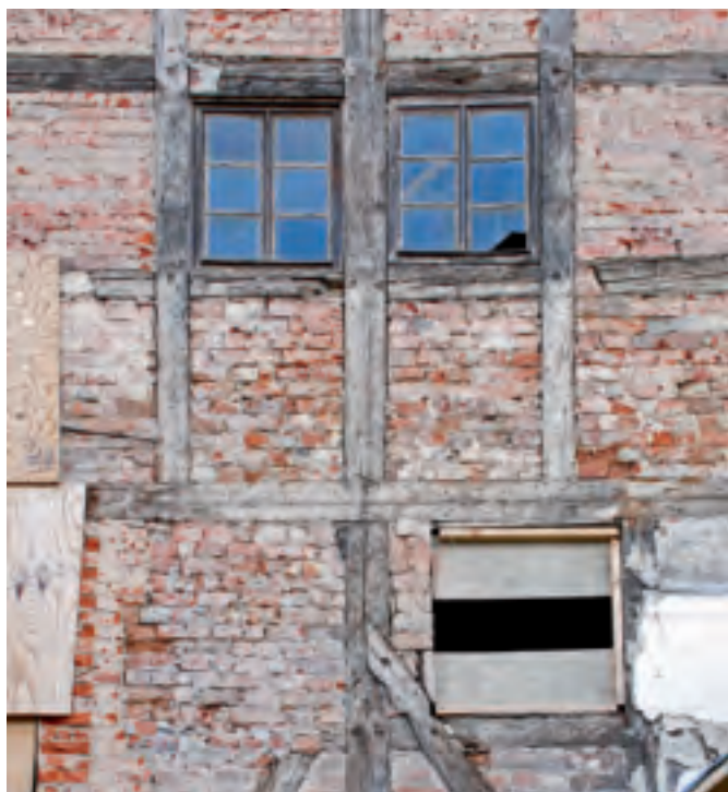
Detail fasády na dvoře
