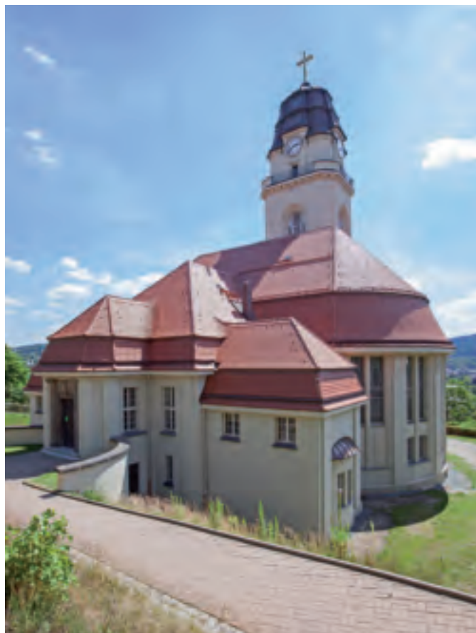
Pohled z úbočí hory na kostel s úžlabími krytými bobrovkami
