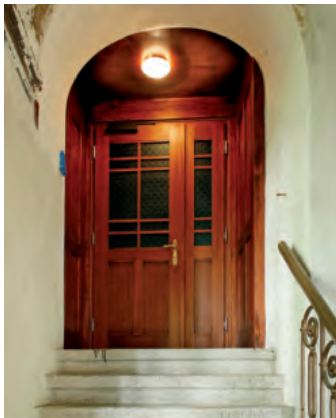
Původní zachované křídlo dveří vedoucí ke schodišti
