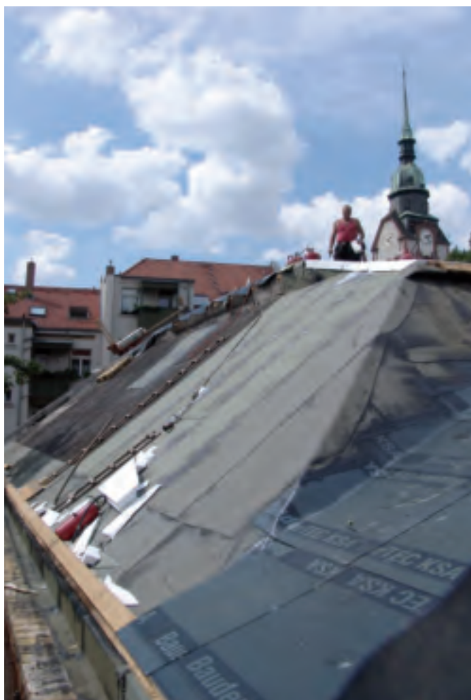
Záběr na střechu při pokládání nové krytiny v roce 2006
