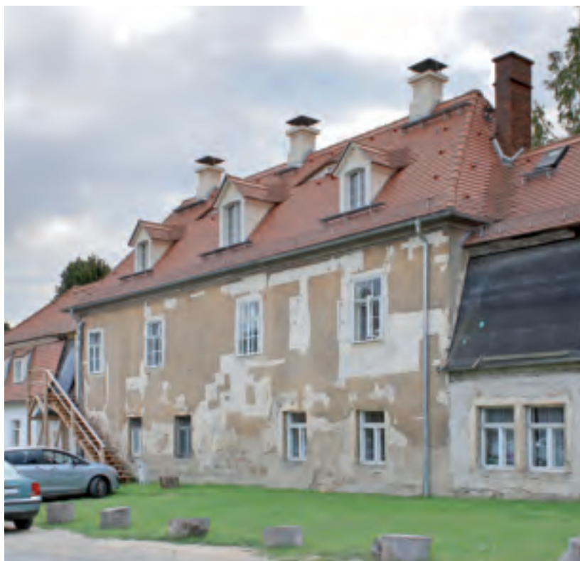
Nová střešní krytina a odkryté vzorky na pouliční fasádě
