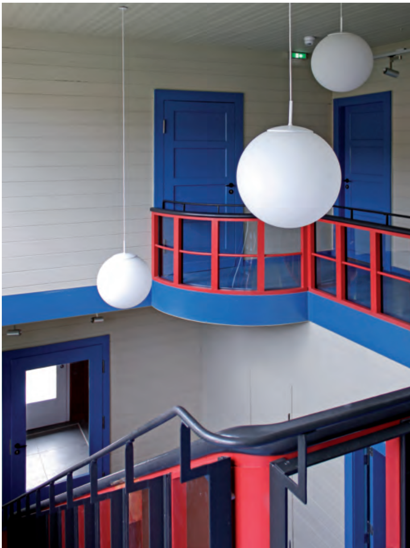
Schodiště v původním barevném provedení
