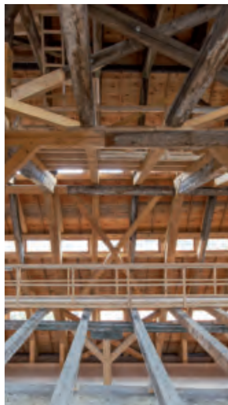
Střešní krov po vyztužení
