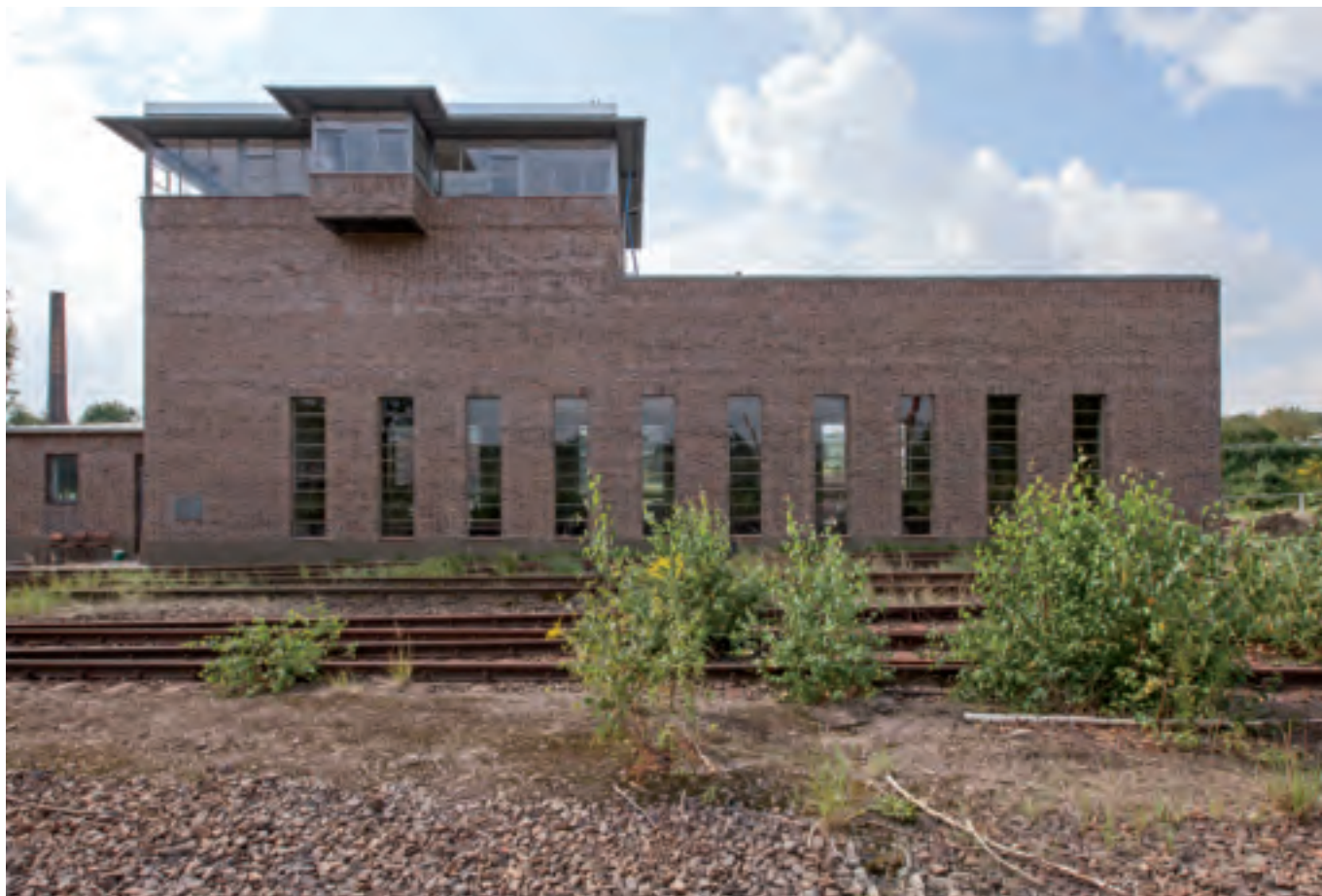
Strojovna spádové lanovky s přistavěným stavědlem 2
