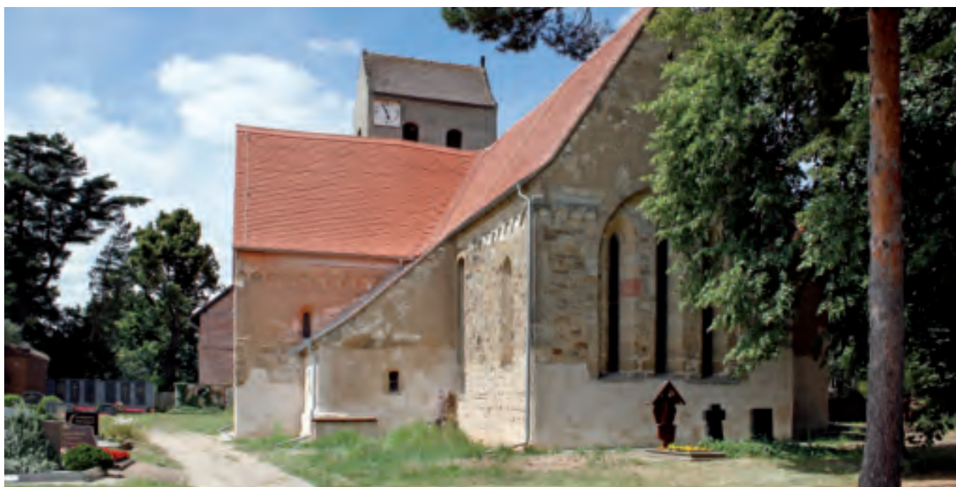
Pohled od východu
