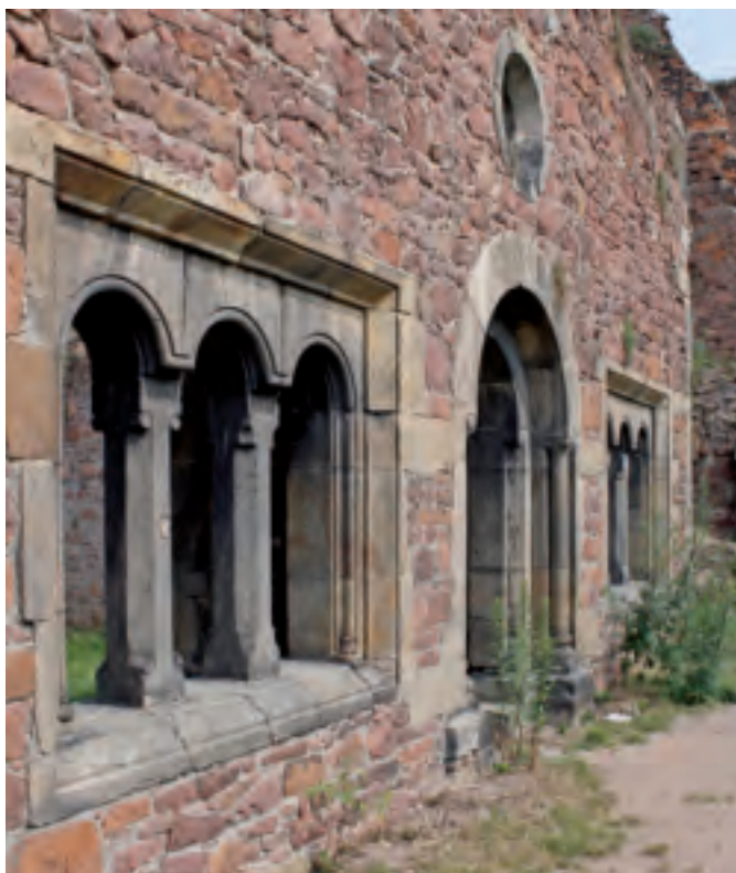
Portál mezi okenními otvory s trojobloukovými lomenými okny
