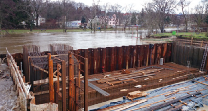
Bau des neuen Verteilerwehres
