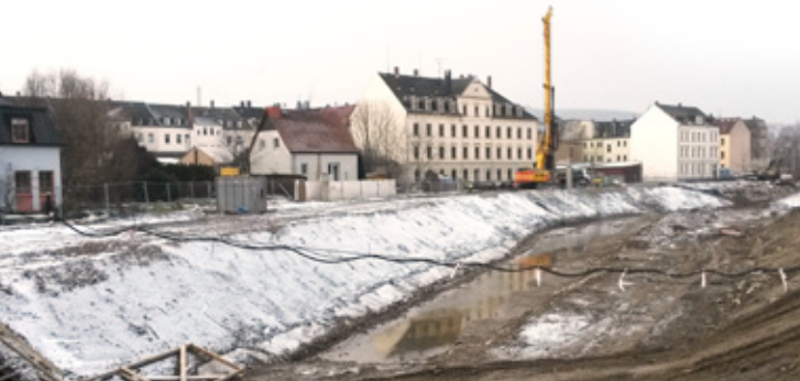
Bauarbeiten an der Flutmulde
