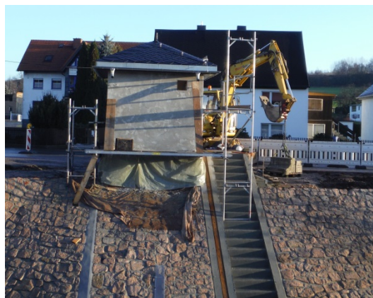
Abb. 32: Pegel Sankt Egidien (Lungwitzbach) kurz vor der Fertigstellung
