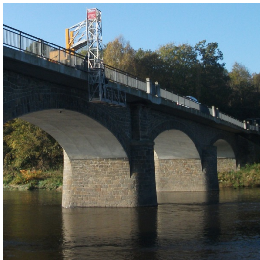
Abb. 22: Montage des Radarsensors Pegel Kössern (Vereinigte Mulde)
