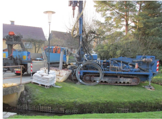
Abb. 26: Bau der Grundwassermessstelle Kiesdorf
