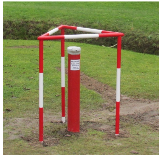
Abb. 27: Fertig gestellte Grundwassermessstelle Kiesdorf
