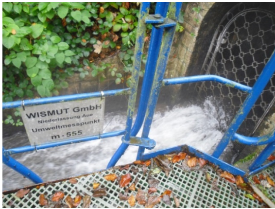
Abb. 14: Messstelle m-555 am Ablauf der Wasserbehandlungsanlage Schlema-Alberoda
