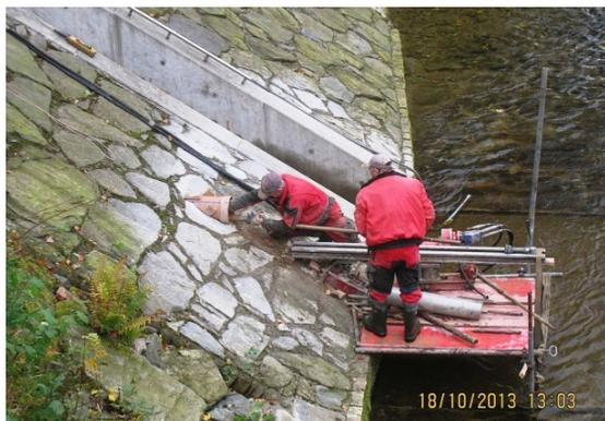
Abb. 23: Einbau eines zusätzlichen Pegelzulaufrohres am Hochwasserpegel Mulde 1
