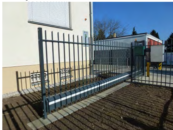
Abbildung 1: LUA-Standort Leipzig – automatische Schiebetoranlage
