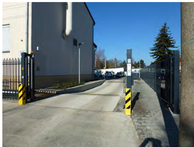
Abbildung 2: LUA-Standort Leipzig – neue Desinfektionsdurchfahrwanne
