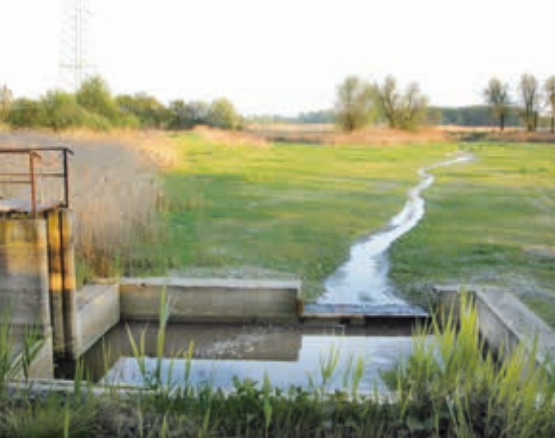
Abb. 4: Typisch für viele Fischteiche der Lausitz, hier der Maxteich (Teichgruppe Kolbitz), ist eine mehr oder weniger befestigte Fischgrube vor dem Auslass. Foto: H. John
