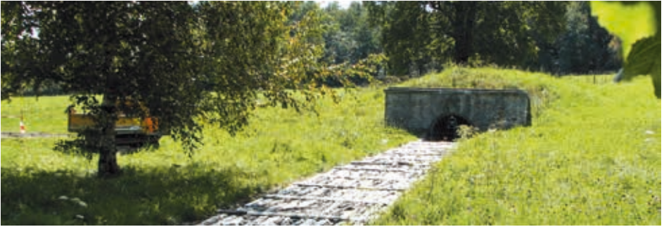
Abb. 7: Die Bergwerksteiche des Erzgebirges sind über ein Kunstgraben- und Röschensystem miteinander verbunden. Abgebildet ist ein mit Holzbohlen abgedeckter Kunstgraben, mit Mundloch und anschließender Rösche. Foto: H. John
