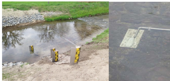
Abb. 2 und 3: Pegel Melpitz mit links: Lattenpegel und Durchflussmessanlage I rechts: Durchflusssensor in der Gewässersohle
