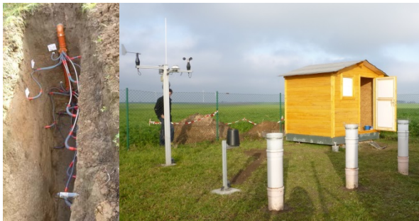
Abb. 5 und 6: BDF II Schmorren links: offener Schurf mit Sonden rechts: fertige Station mit Gerätehaus, Klimastation und Bulk-Sammlern
