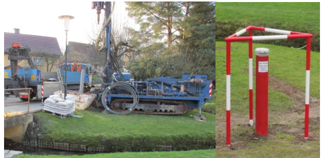
Abb.7 und 8: links: Bau der GWM | rechts: fertig gestellte GWM Kiesdorf
