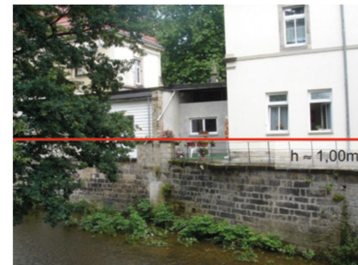
Erhöhung der Ufermauern an der Gottleuba – Beispiele für gewässernahe Bebauung mit Sonderlösungen
