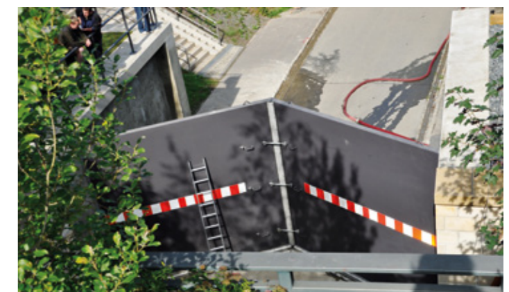
Hochwasserschutztor am Durchlass Ecke Klosterstraße / Rosa-Luxemburg-Straße
