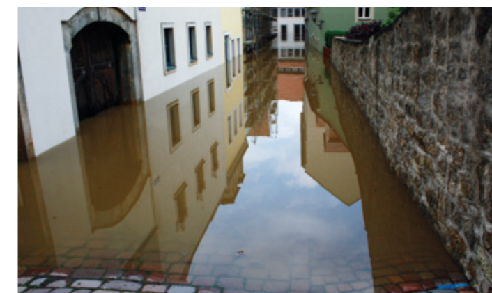
Pirnaer Altstadt bei Hochwasser
