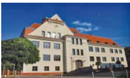
Grundschule »Am Park« Schulstraße 2, 02977 Hoyerswerda
