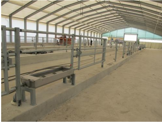
Abbildung 107: Neu verlegter Spaltenboden und neu gebauter Jungviehstall
