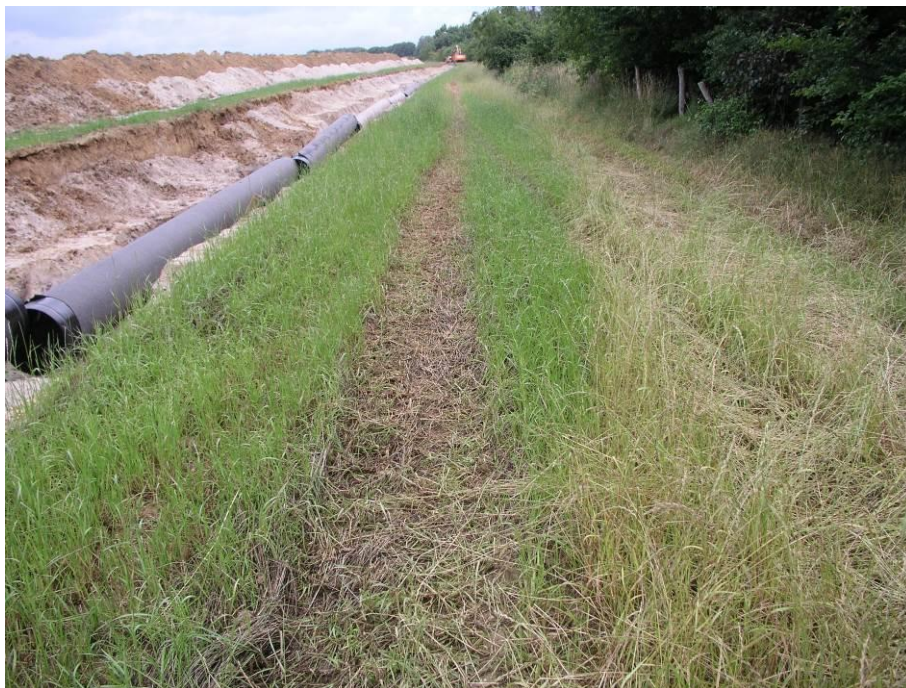
Abbildung 23: Begrünte Fahrtrasse bei einer Rohrleitungsbaustelle
