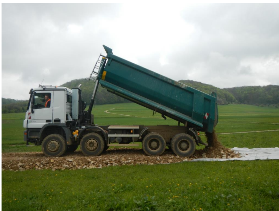
Abbildung 24: Rückwärtiges Anschütten einer temporären Baustraße auf dem A-Horizont (Foto: regioplus-Ingenieurgesellschaft)
