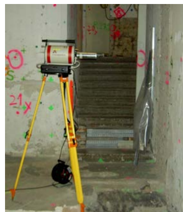
Abb. 2: Messung mit Blick auf die Wand
