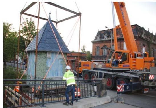
Abb. 5: Umsetzen des Stationsgebäudes des Pegels Dresden-Friedrichstadt (Vereinigte Weißeritz), (ehemals Pegel Cotta)
