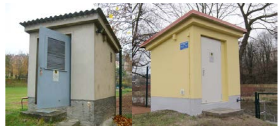
Abb. 3 und 4: Pegel Görlitz (Lausitzer Neiße) vor und nach der Sanierung
