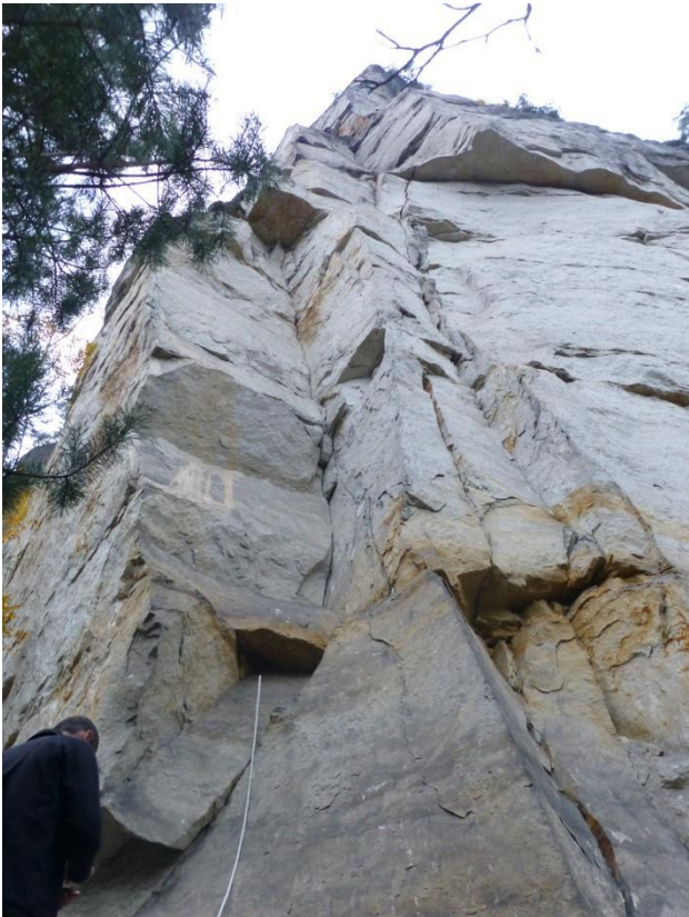
Abb. 3: Vom Gesteinsverband durch Kluft getrennter Fels-turm
