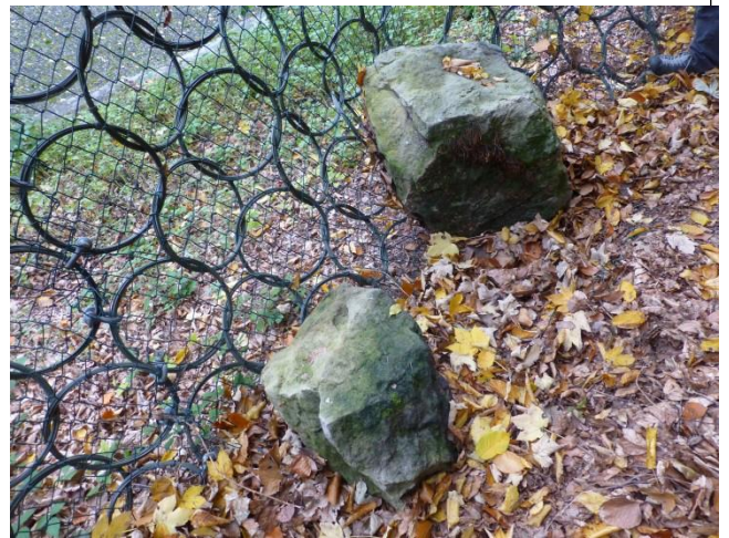
Abb. 2: Durch Steinschlagschutznetz zurückgehaltene Steine
